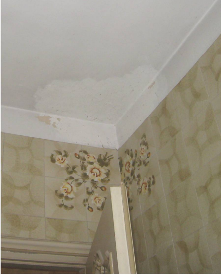
infiltrazioni dal servizio igienico nel sottotetto
