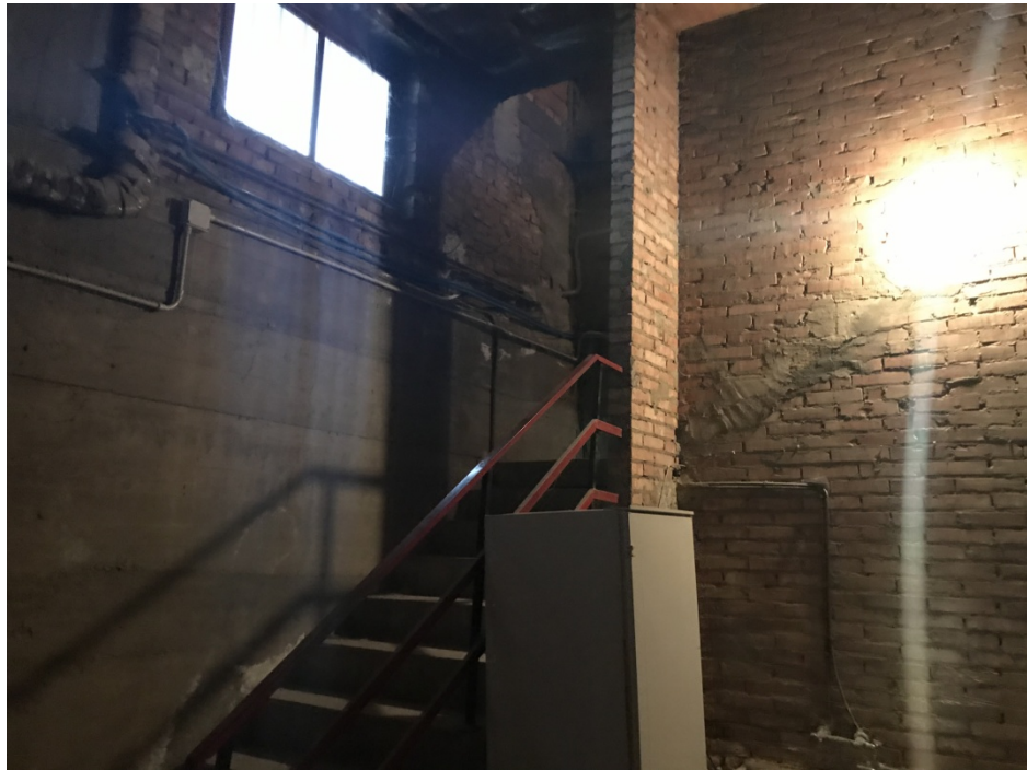
Foto n. 3 – scala di collegamento
