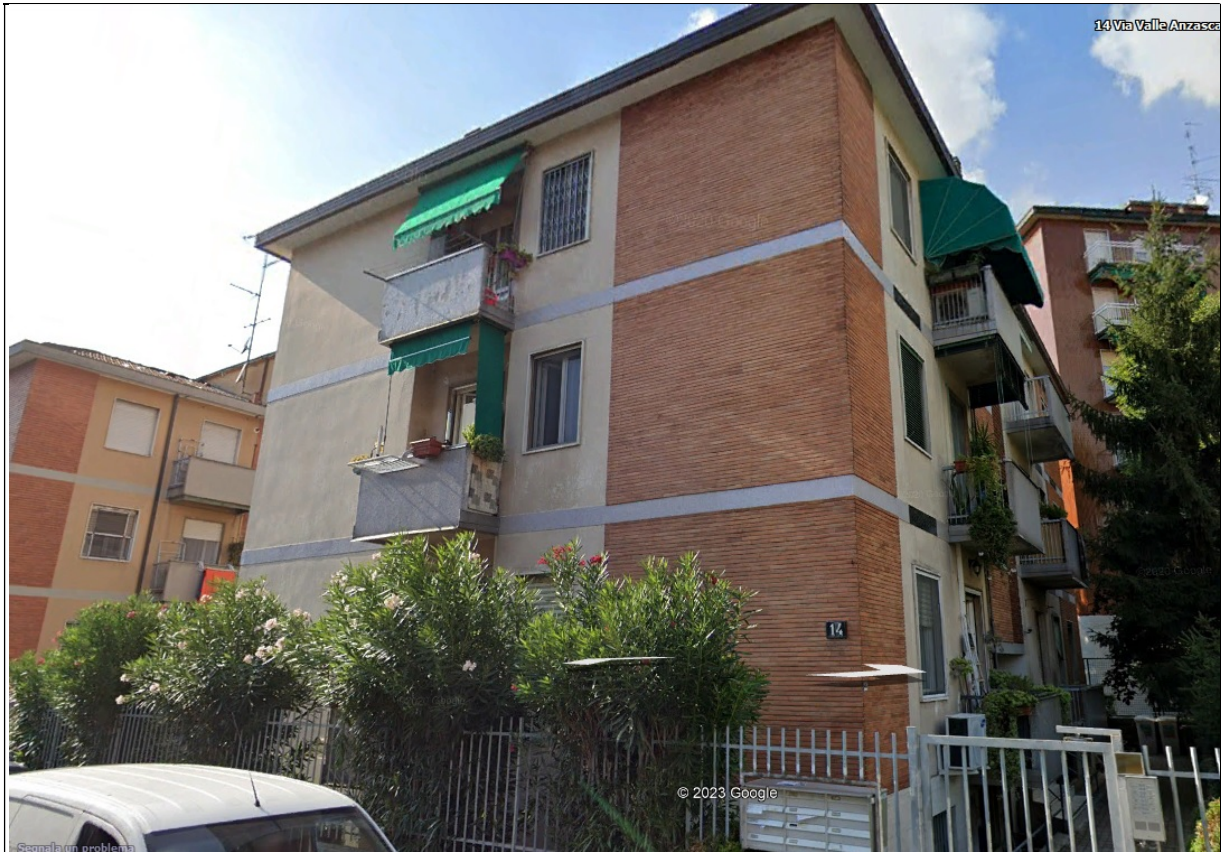
Immagine fabbricato visto da Via Valle Anzasca tratta da google.it
