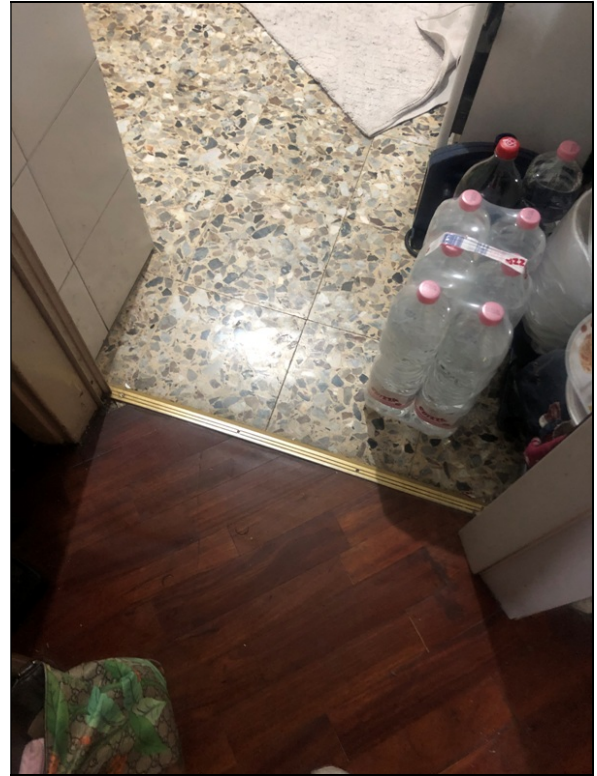
DETTAGLIO PAVIMENTO TRA CORRIDOIO E CUCINA
