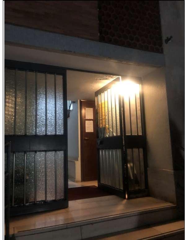
PORTONE DI INGRESSO AL FABBRICATO
