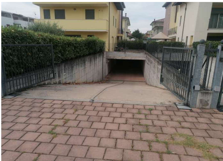
Vista dell'accesso al garage
