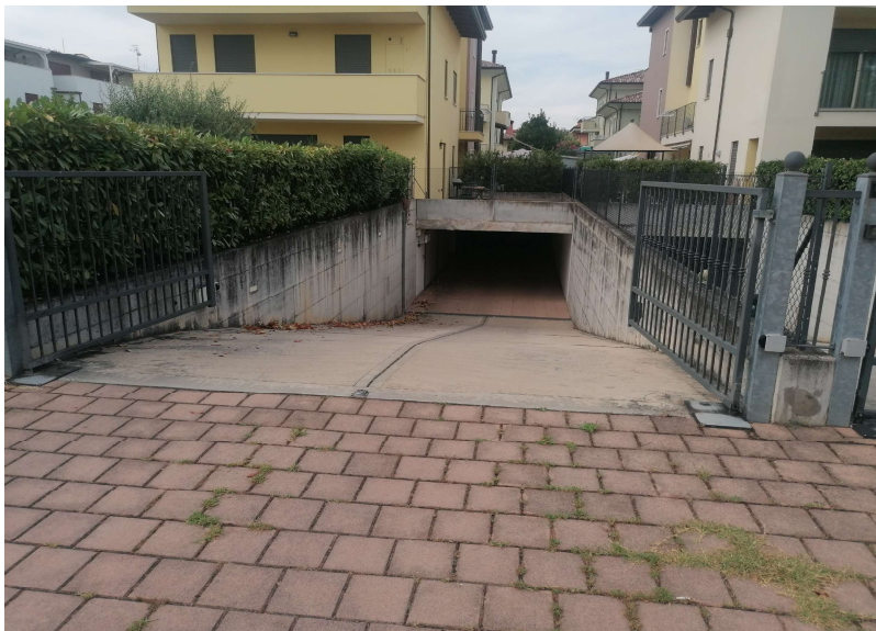
Vista del fabbricato condominiale dalla pubblica via Tasso
