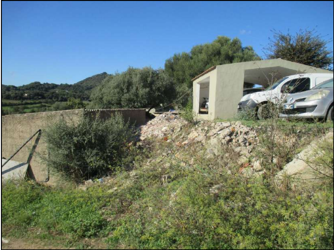
Vista da est del parcheggio coperto.
