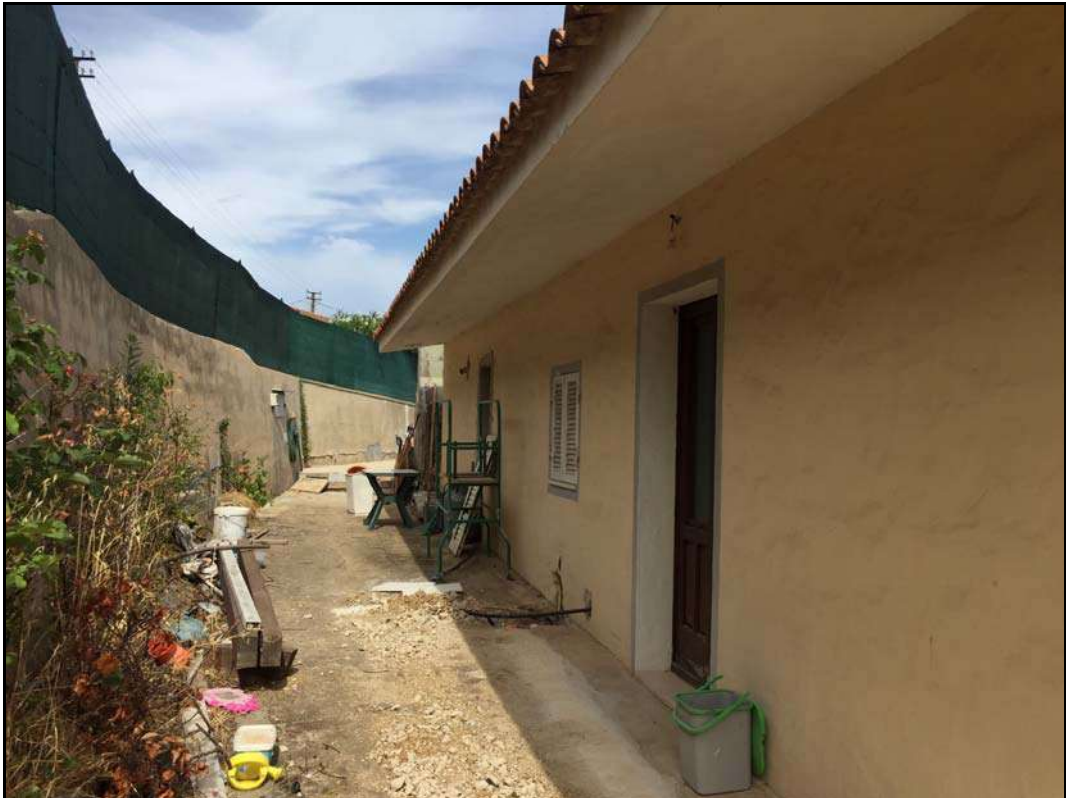
Vista del retro dell'edificio.
