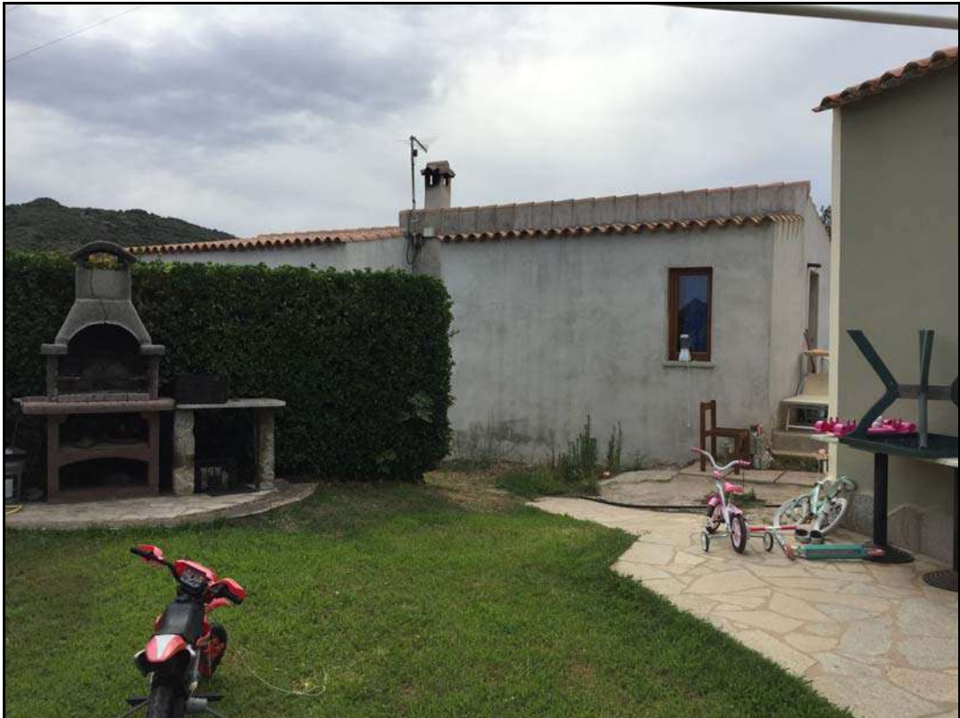
Vista di scorcio dell'immobile abusivo.
