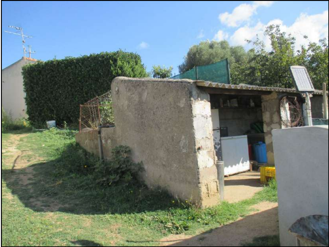
Vista di una tettoia abusiva presente all'interno della proprietà.
