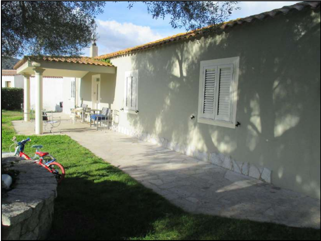
Vista dell'ingresso al Sub1.
