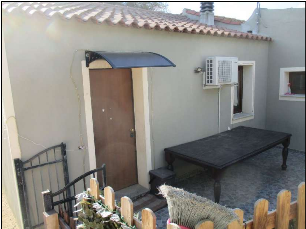
Vista dell'ingresso all'appartamento identificato con il Sub 2.
