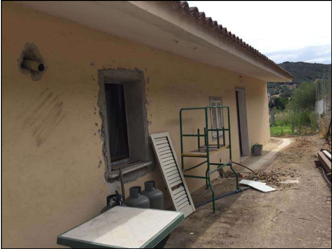
Vista del retro dell'edificio.
