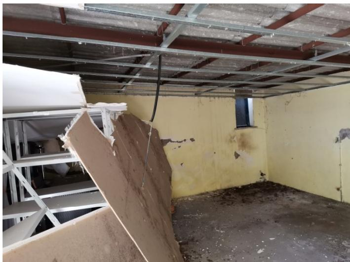
La copertura in eternit, le infiltrazioni e la caduta della controsoffittatura
