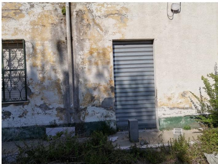
Il prospetto e le evidenti infiltrazioni con ammaloramento dei rivestimenti esterni
