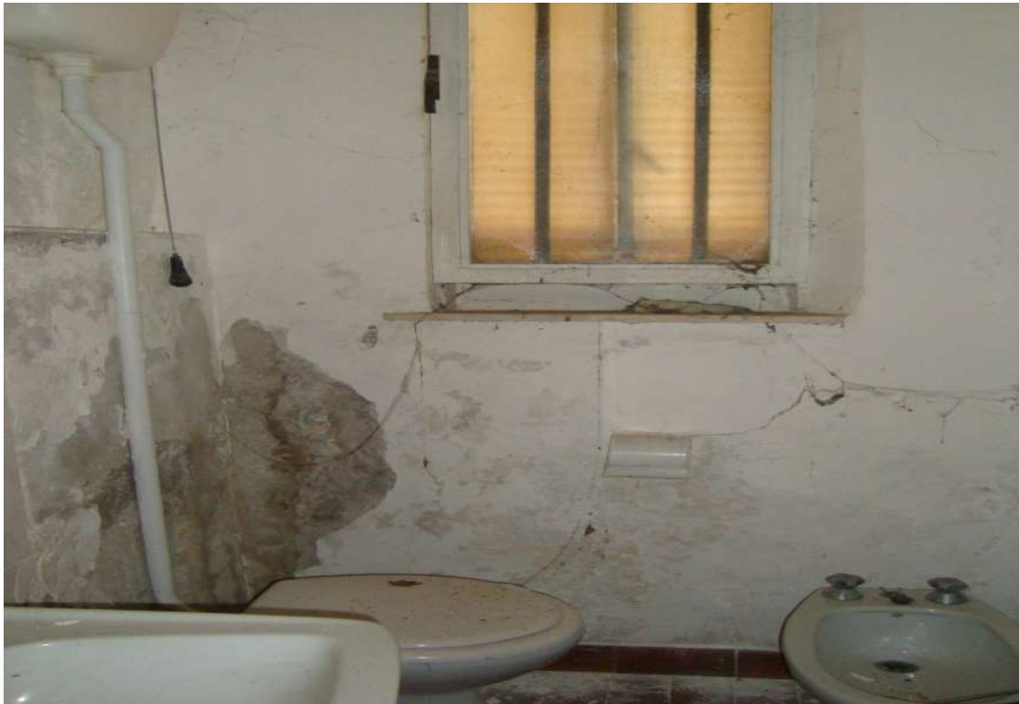
foto n°9 “Servizi igienici ricavati fuori sagoma ed oggetto di ripristino ”
