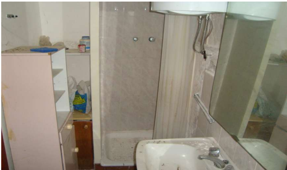
foto n°10 “Servizi igienici ricavati fuori sagoma ed oggetto di ripristino, altra vista ”
