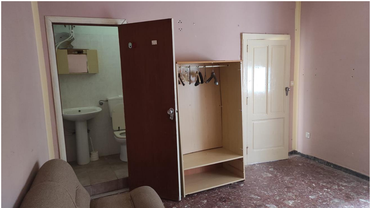
Servizio igienico e vano piano primo
