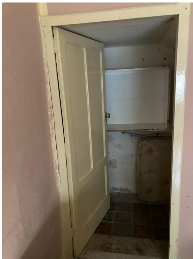
Ripostiglio piano primo
