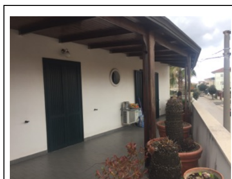
Immagine n. 27 – balcone 4 + tettoia
