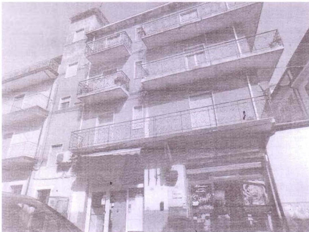
Foto 03. Fabbricato in Via della Pietà contenente le unità immobiliari pignorate
