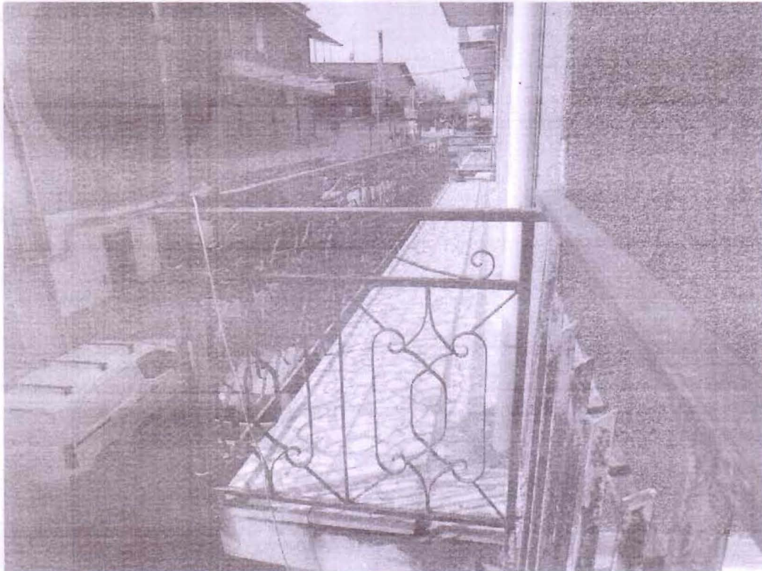
Foto 23. Vista del balcone su Via della Pietà
