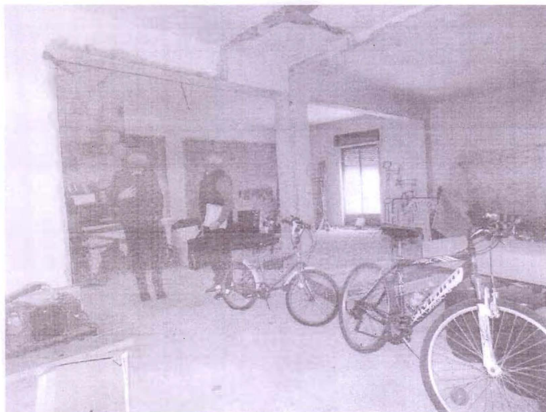
Foto 18. Interno dell'appartamento al primo piano
