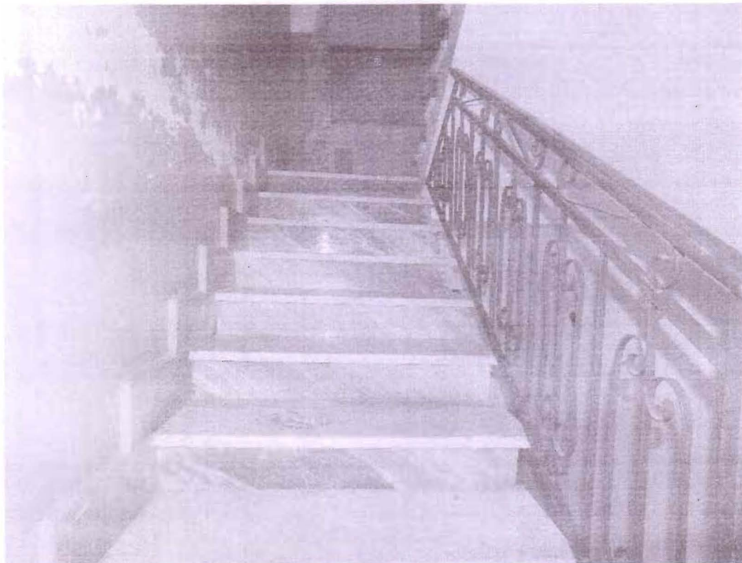
Foto 24. Rampa di arrivo al terzo piano
