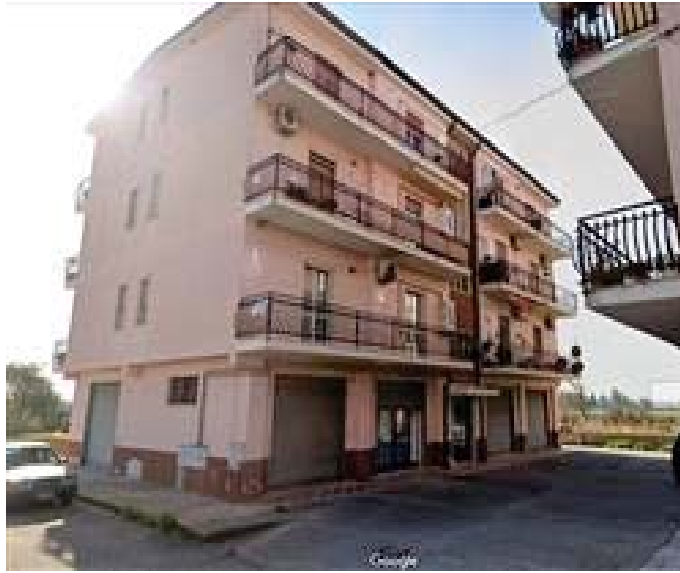
palazzina in oggetto
