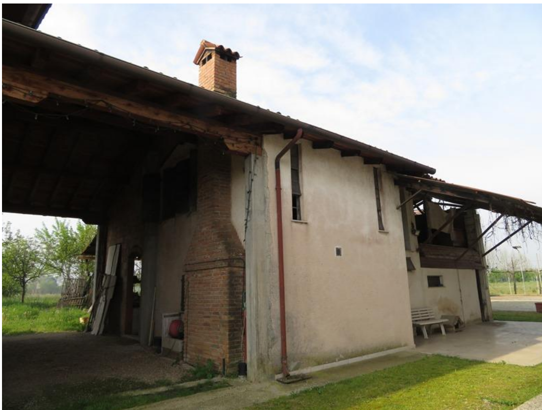
Vista del fabbricato
