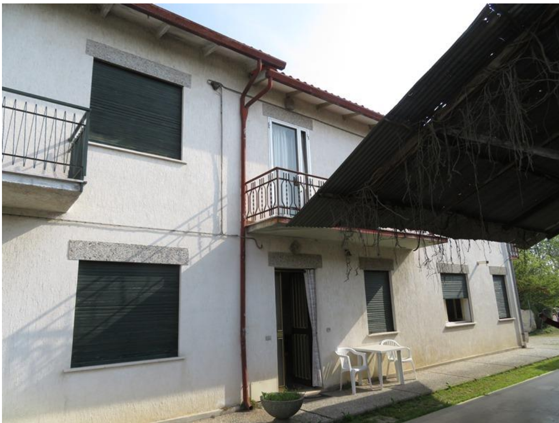
Vista del fabbricato
