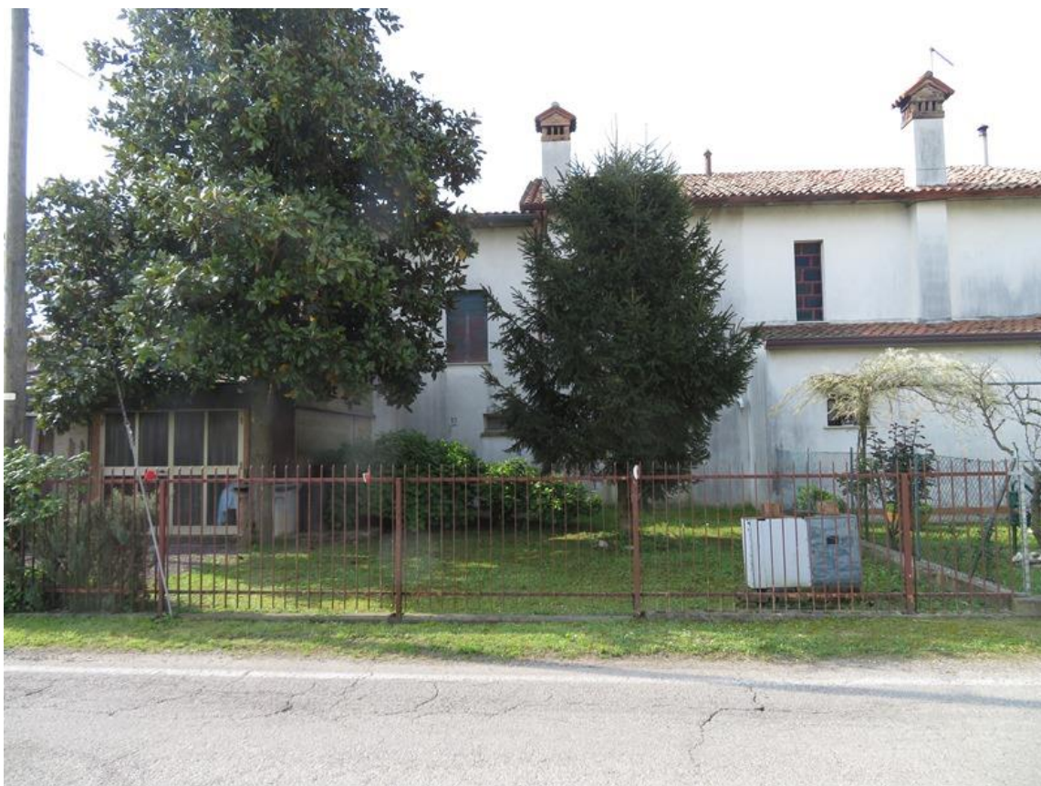
Vista del fabbricato
