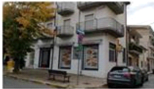
Foto del fabbricato
