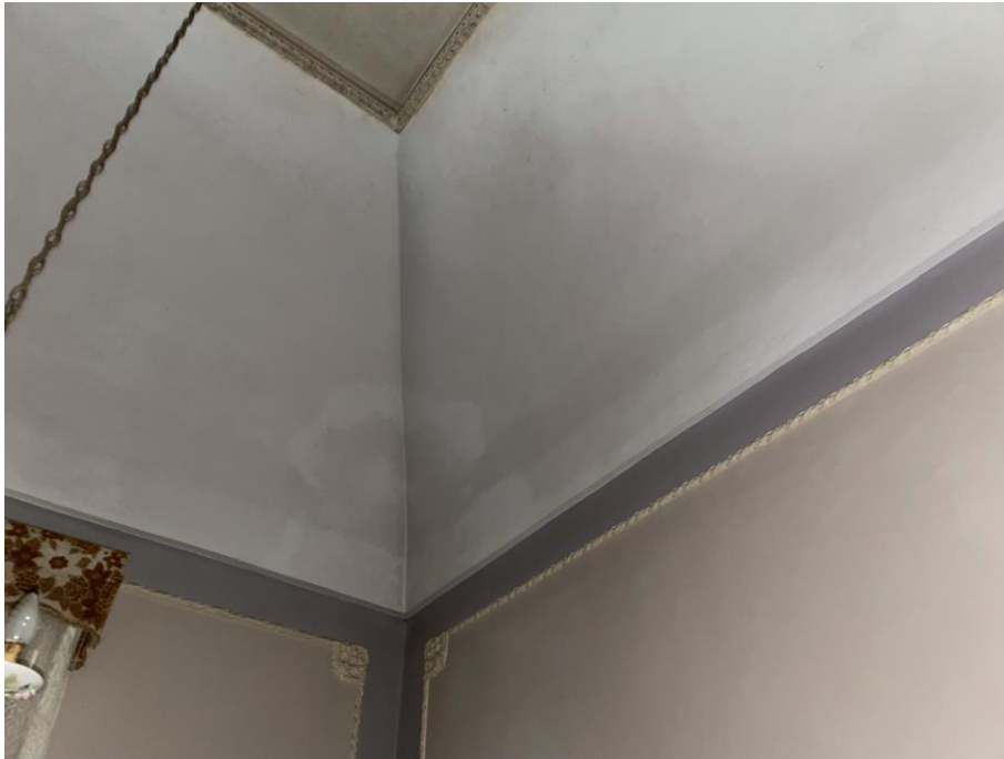
FOTO 13: EFFLUORESCENZE SALINE
