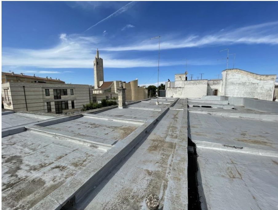
FOTO 18: VISTA LASTRICATO SOLARE
