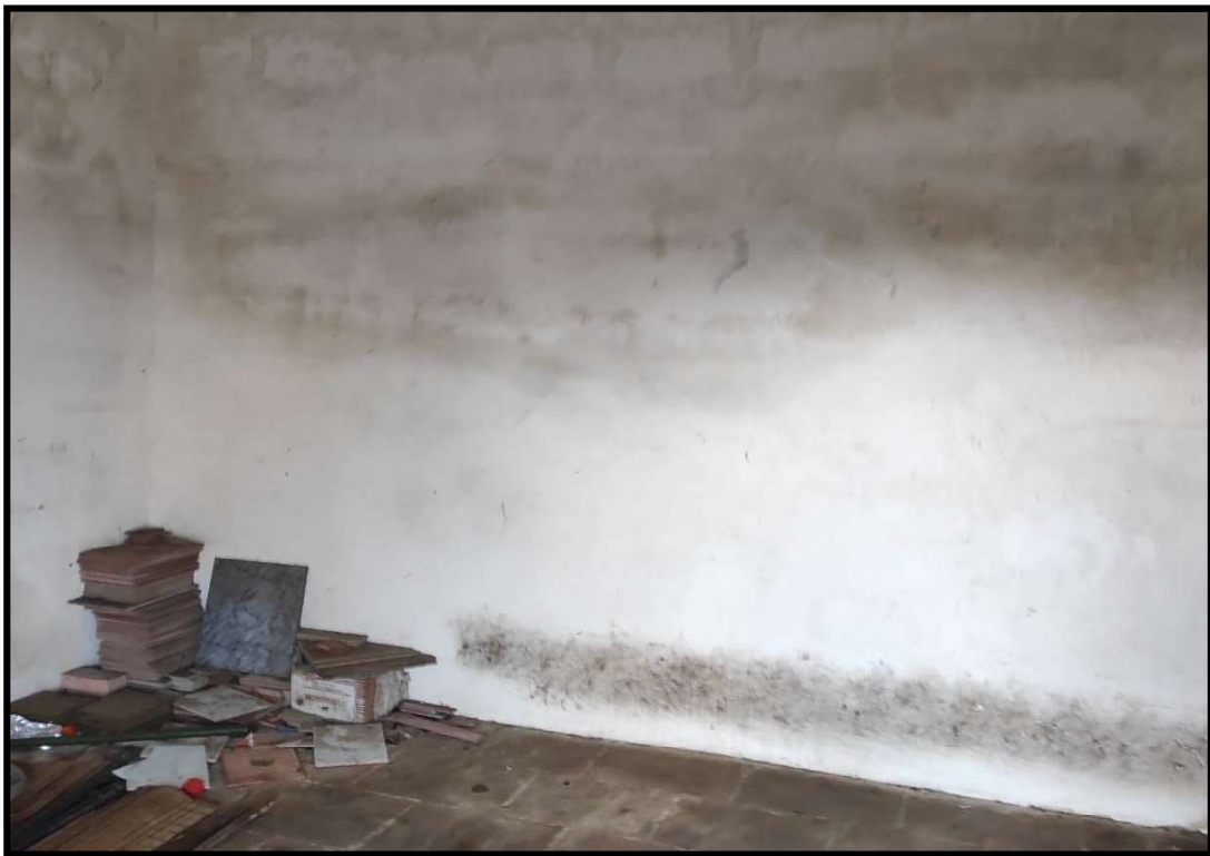
Vano Deposito Piano Terrazza
