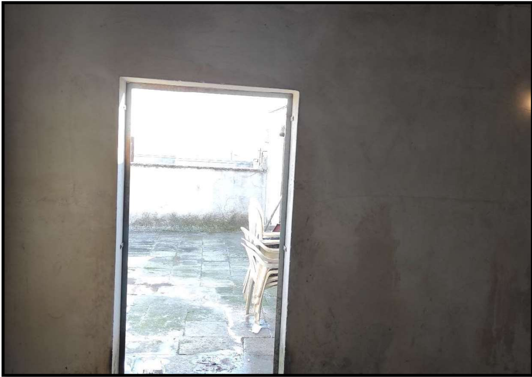
Vano Deposito Piano Terrazza
