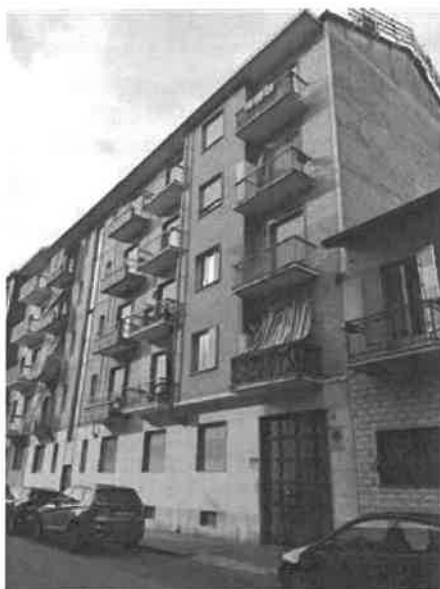
Veduta prospetto est dell'edificio su via Nomaglio, con androne carraio al n.c.v. 5
