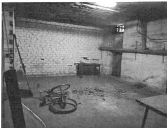
Interno locale al p.s. oggetto di pignoramento
