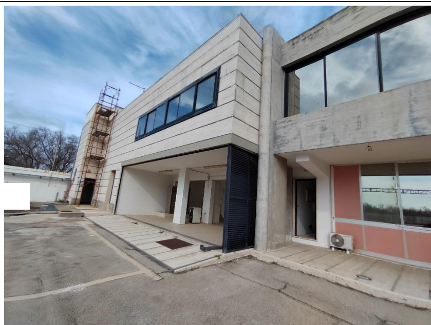
Figura 18: Corpo B e ingresso ai laboratori al piano terra
