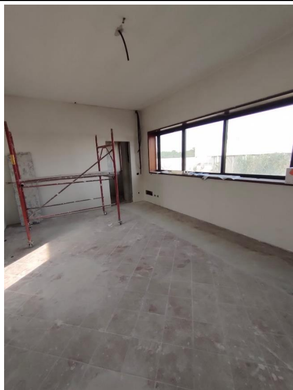
Figura 14: Interno uffici non ultimati
