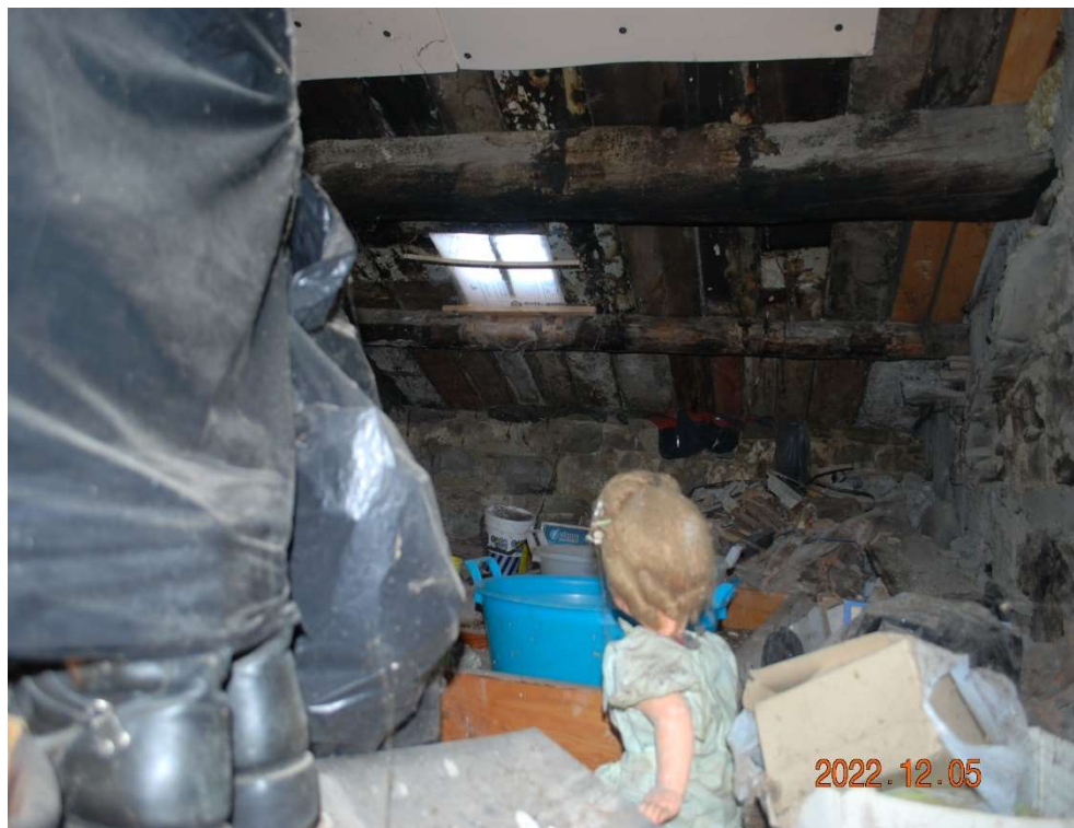
Foto 24 Sottotetto falda anteriore
