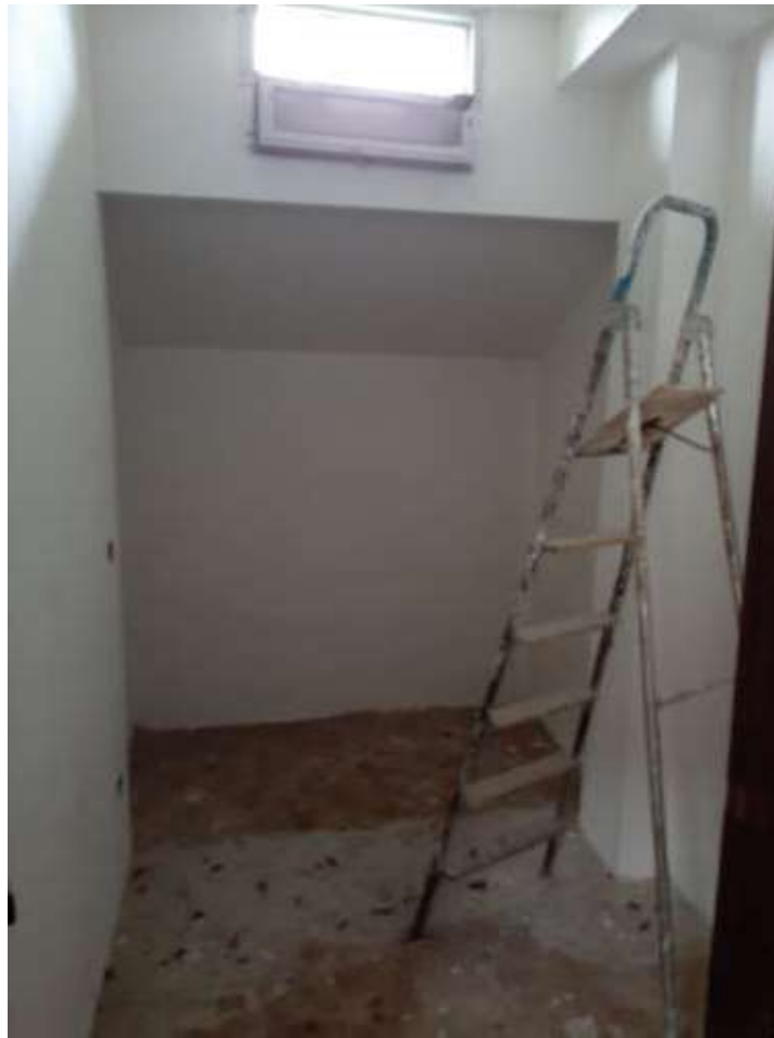
Foto n.15 (dispensa piano primo)
