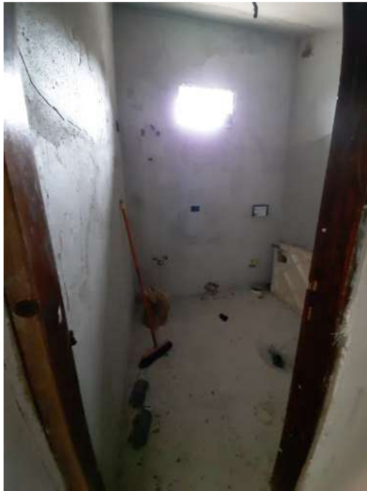
Foto n.21 (wc piano secondo)
