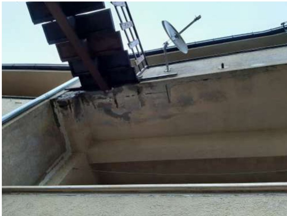
Foto n.5 (particolare scala esterna)
