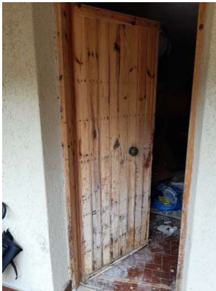
Foto n.6 (porta di accesso loc. garage)
