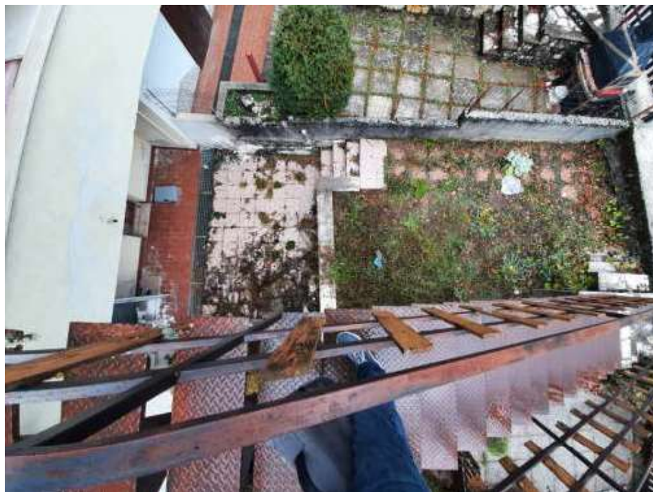
Foto n.9 (vista corte da piano primo)
