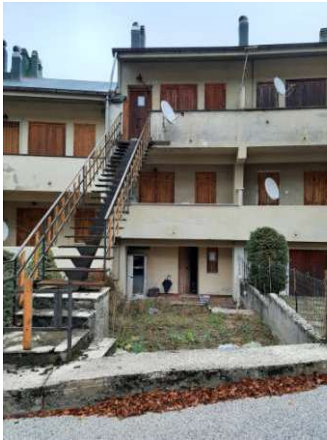
Foto n.1 (vista da strada condominiale)
