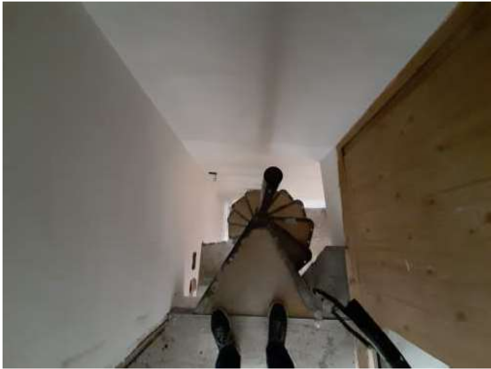
Foto n.18 (particolare scala interna)
