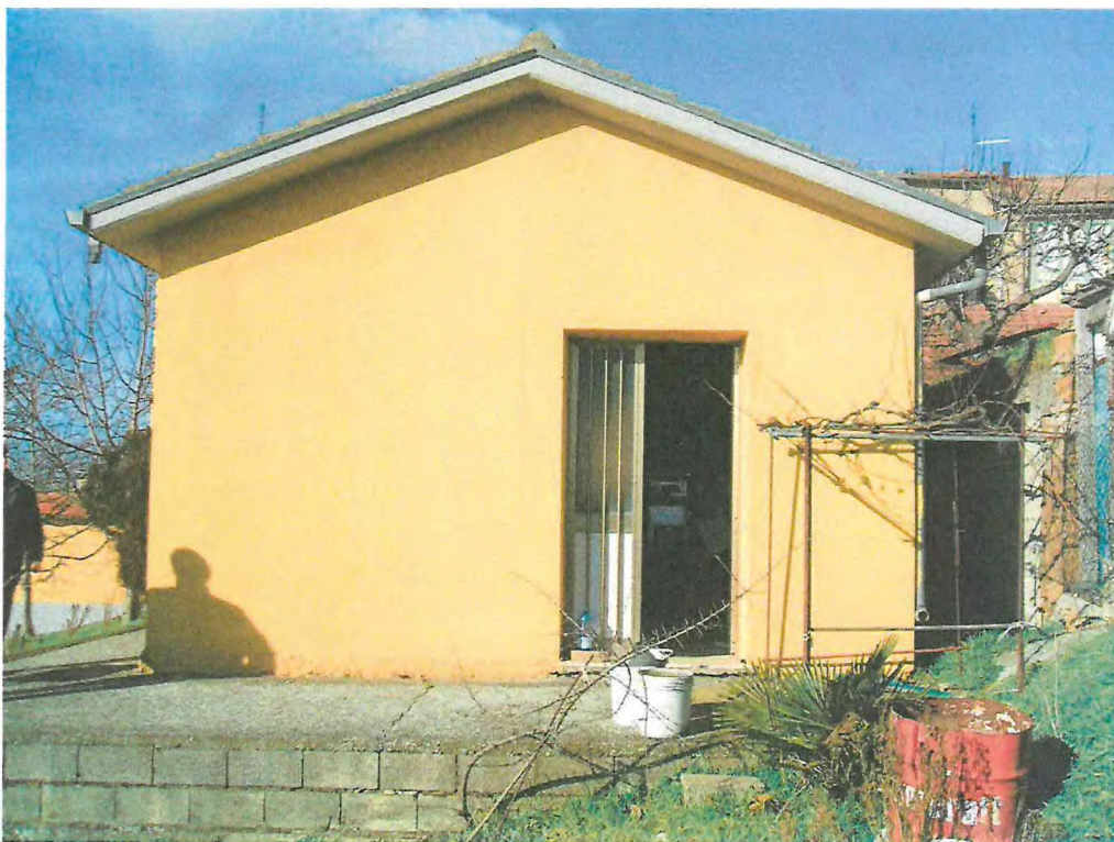
FOTO 23. Fabbricato adibito a deposito (part.1744): ingresso
