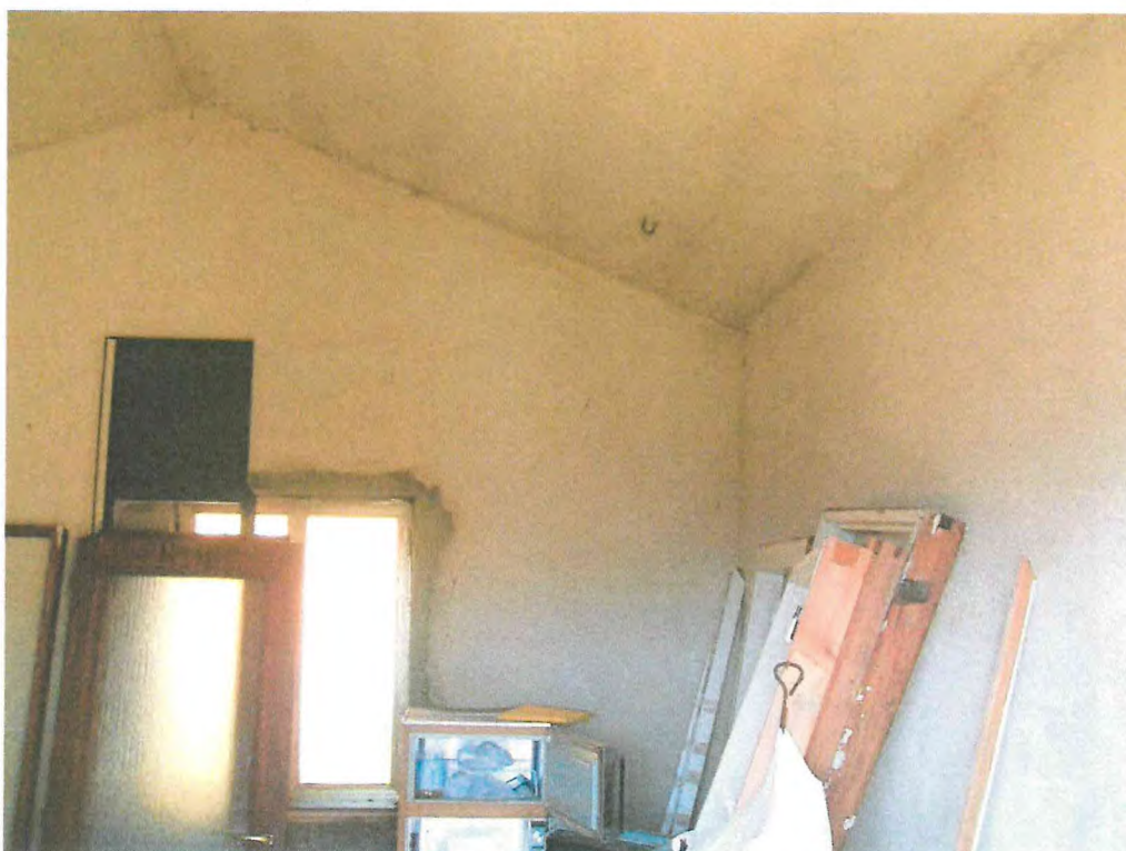
FOTO 24. Fabbricato adibito a deposito (part.1744): interno
