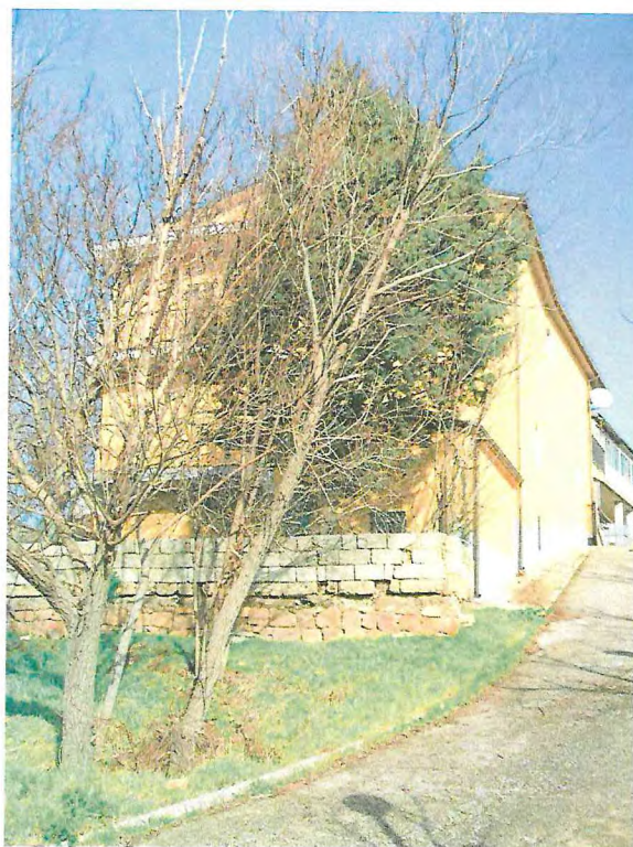
FOTO 1. Immobile lato esterno sud
