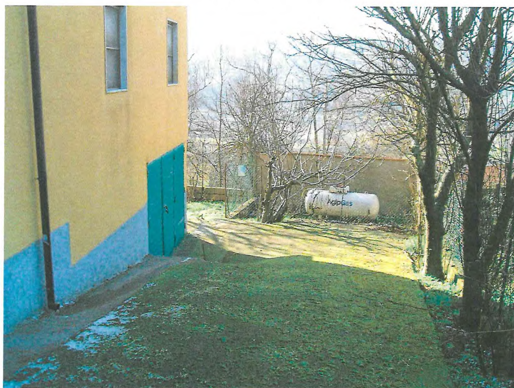
FOTO 22. Primo piano sottostrada: ingresso
