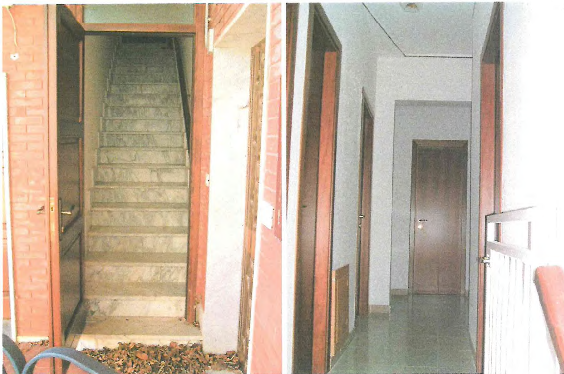
FOTO 11. Ingresso al primo piano
