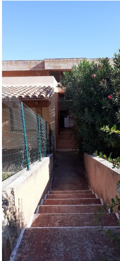
Accesso all'appartamento da sud
