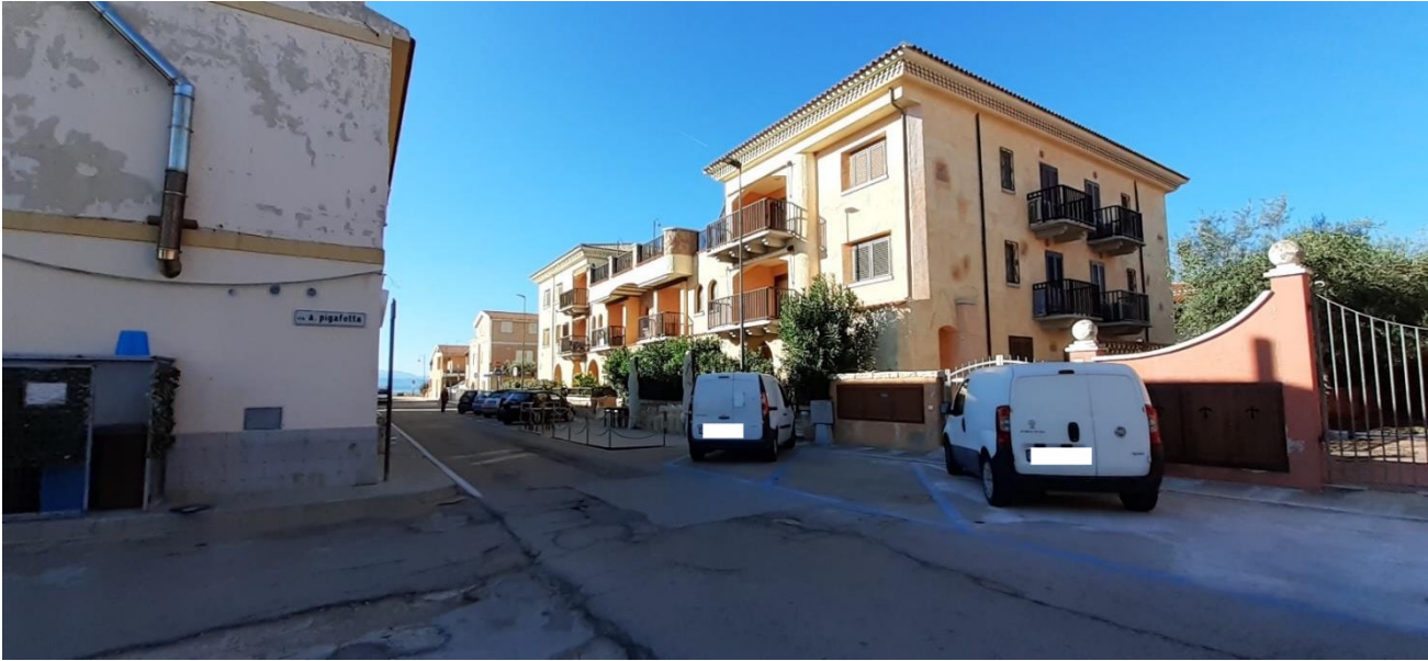
Figura 2: Complesso condominiale LE TERRAZZE DEL GOLFO in via da Verrazzano 4
