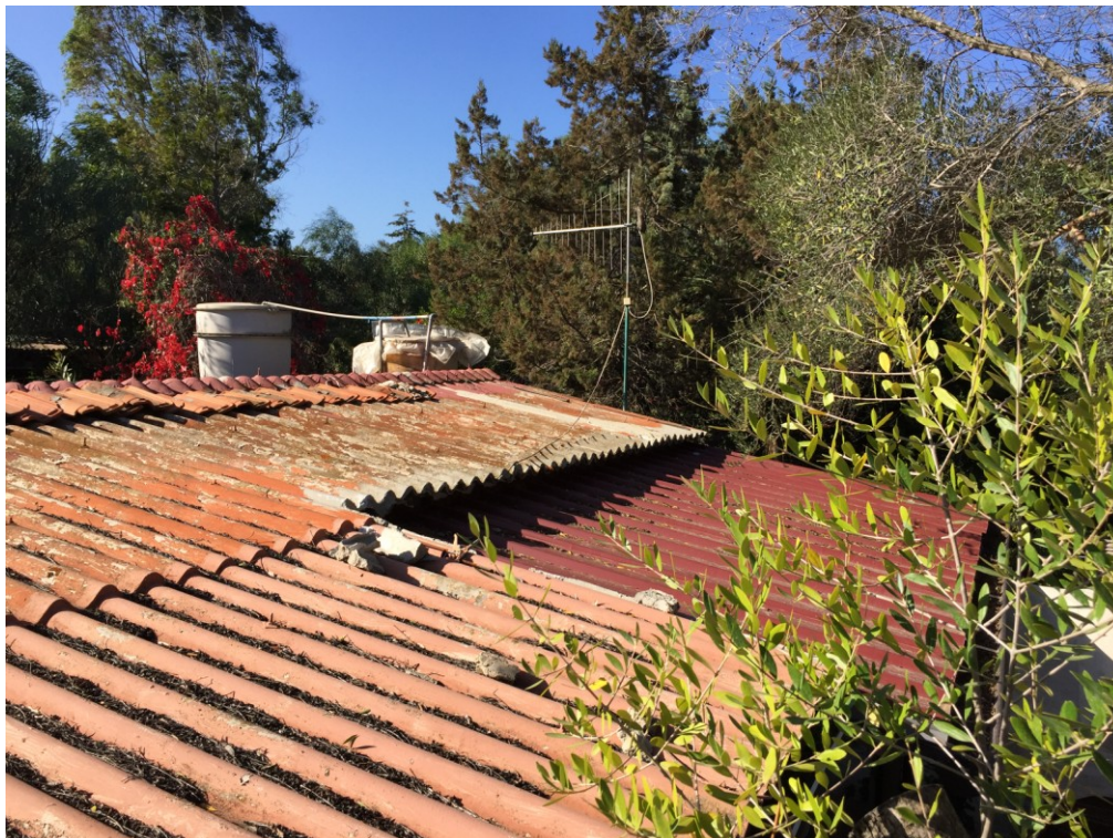
Foto n. 27: copertura abitazione CEA
