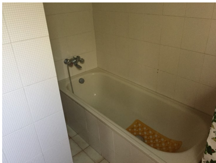
Foto n. 31 particolare bagno abitazione CEA
