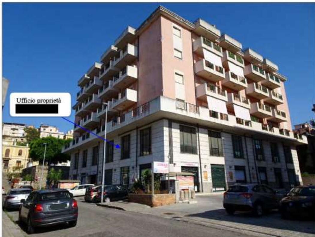
Foto 3: Vista prospetto esterno fabbricato [redacted] Villa San Giovanni
