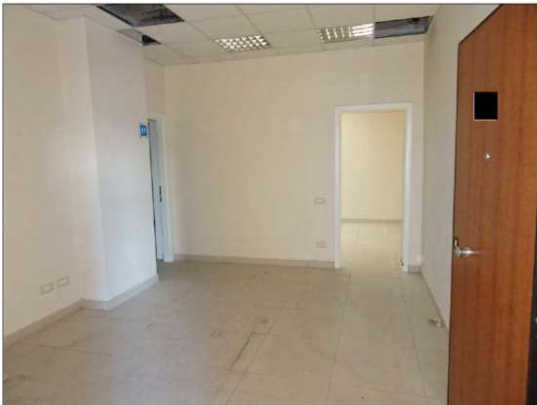
Foto 12: Vista ingresso ufficio
