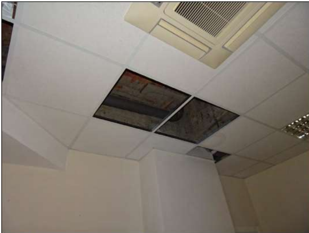
Foto 40: Vista particolare controsoffitto
