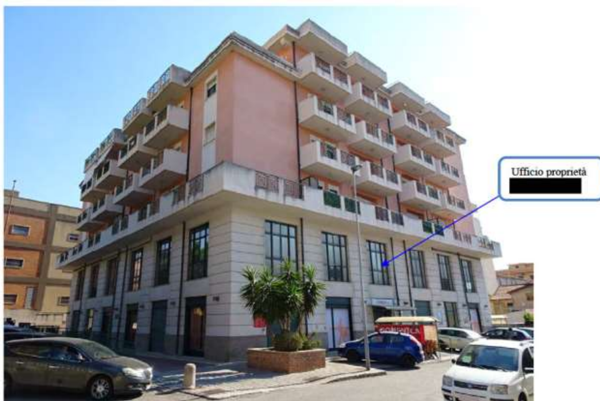
Foto 4: Vista prospetto esterno fabbricato [redacted] Villa San Giovanni
