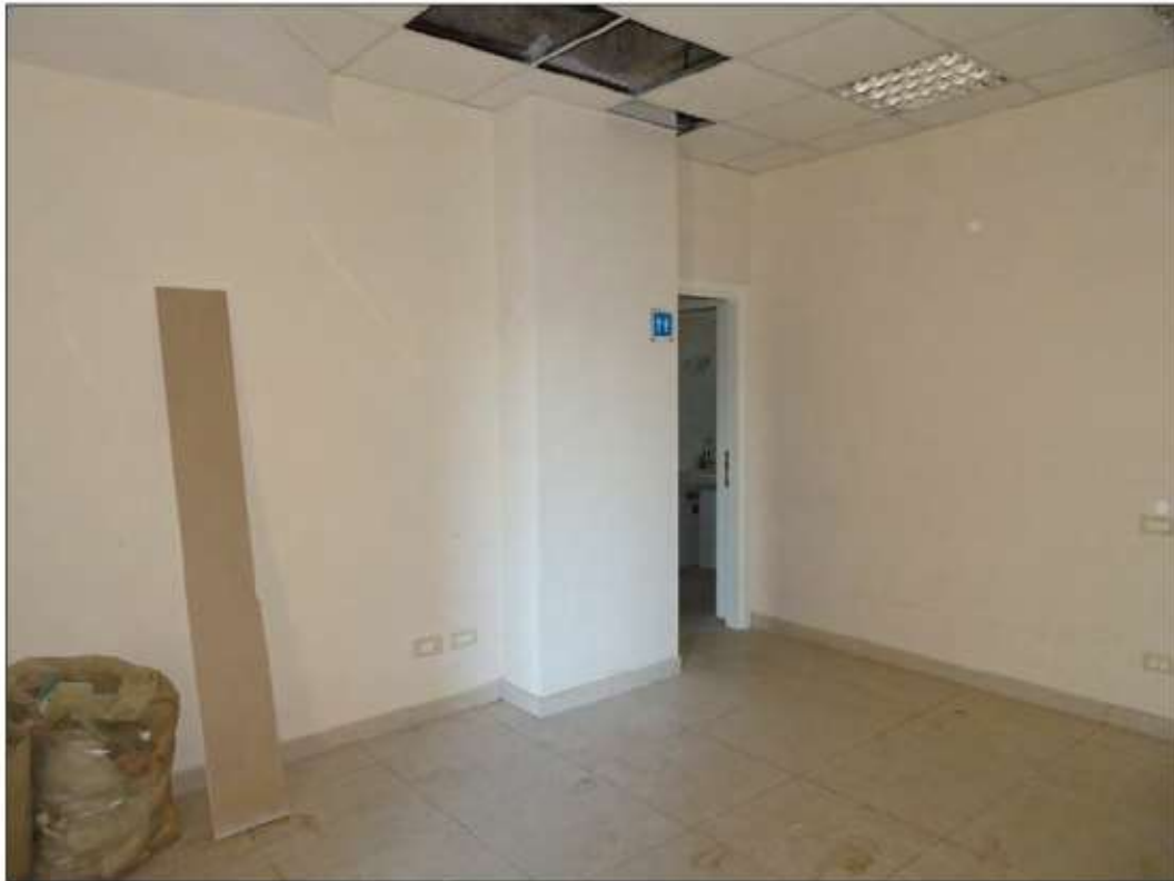
Foto 11: Vista ingresso ufficio
