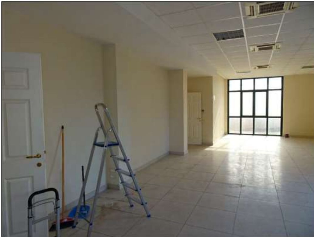
Foto 39: Vista vano ufficio
