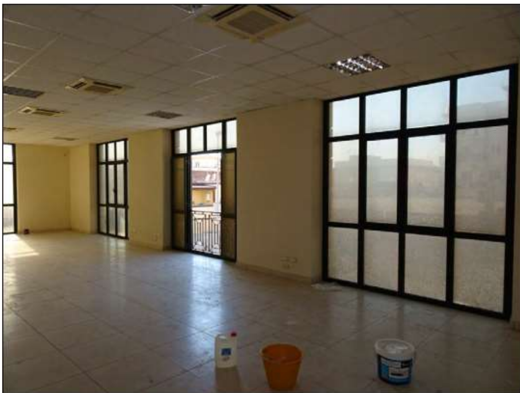
Foto 38: Vista vano ufficio
