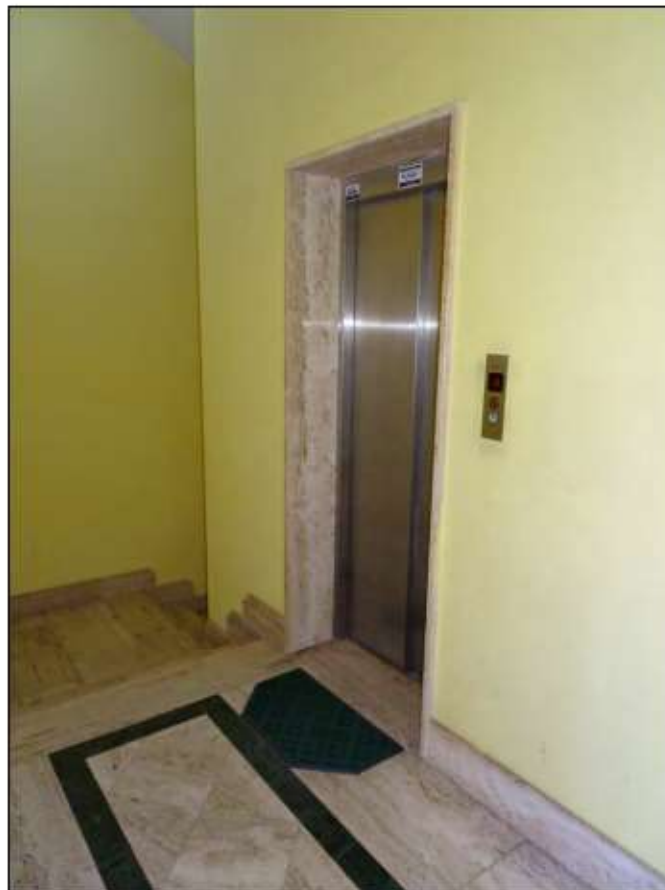
Foto 8: Vista vano ascensore condominio
