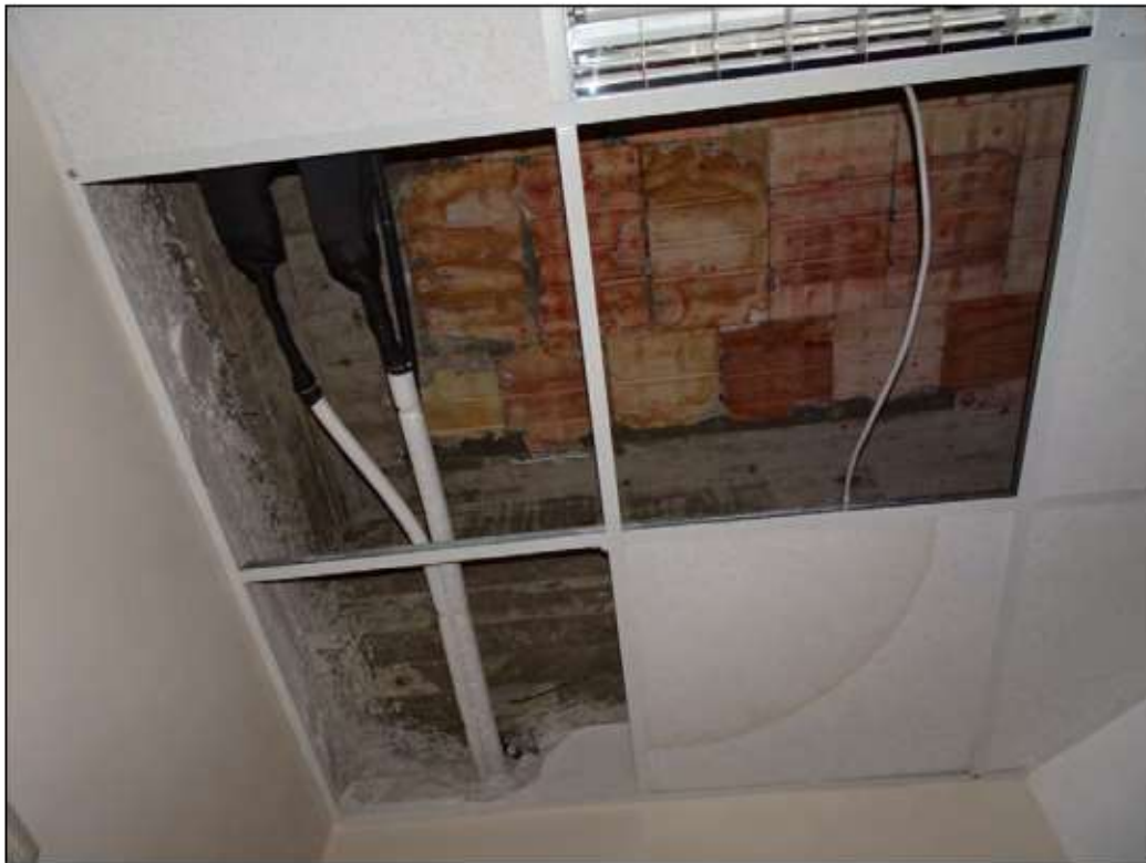
Foto 41: Vista particolare controsoffitto
