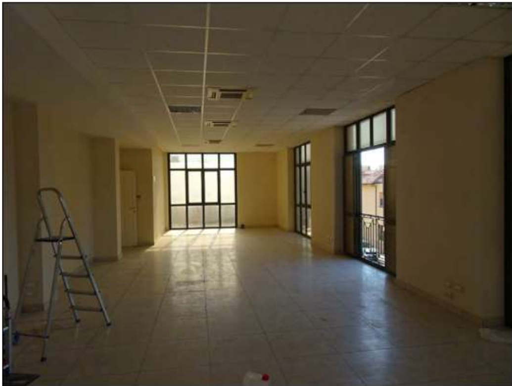
Foto 37: Vista vano ufficio
