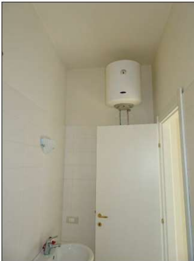
Foto 32: Vista wc vano ufficio
