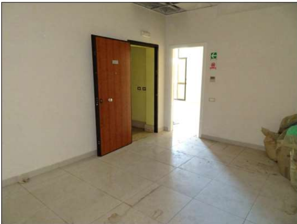
Foto 10: Vista ingresso ufficio
