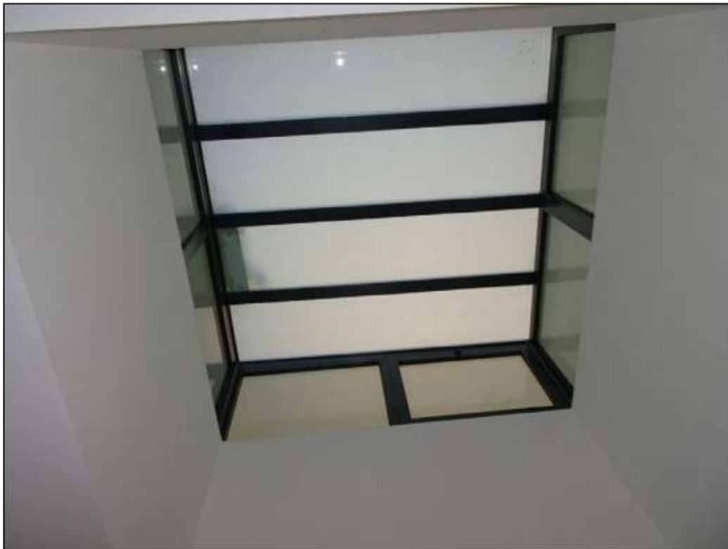
Foto 25: Vista particolare lucernario
