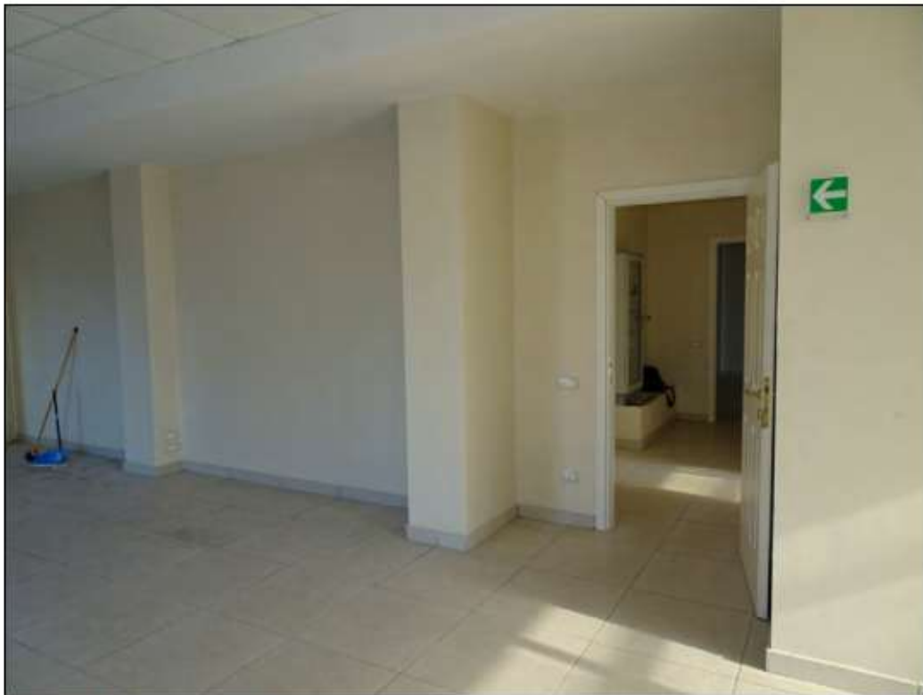
Foto 36: Vista vano ufficio
