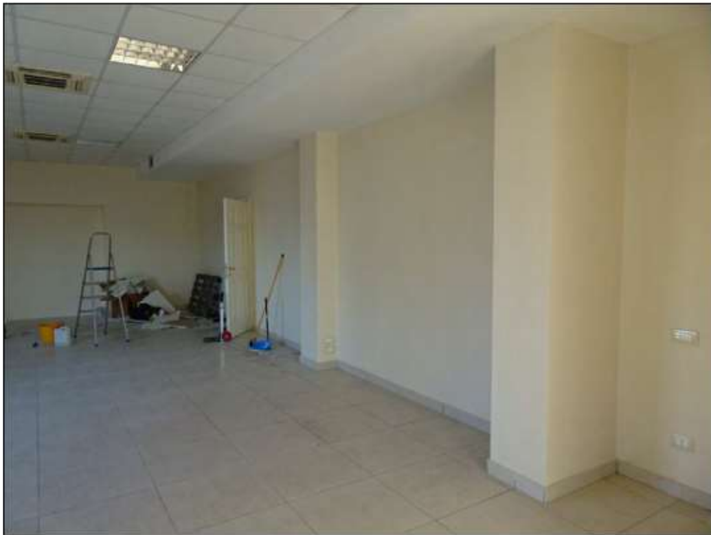
Foto 35: Vista vano ufficio
