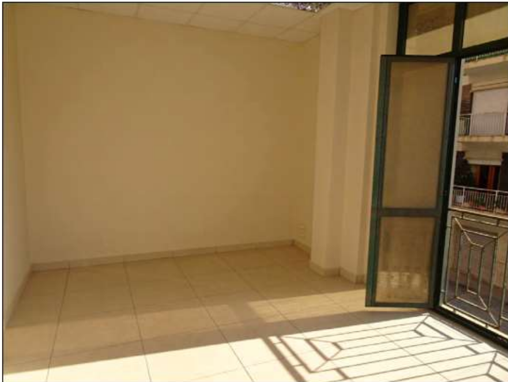
Foto 28: Vista vano ufficio
