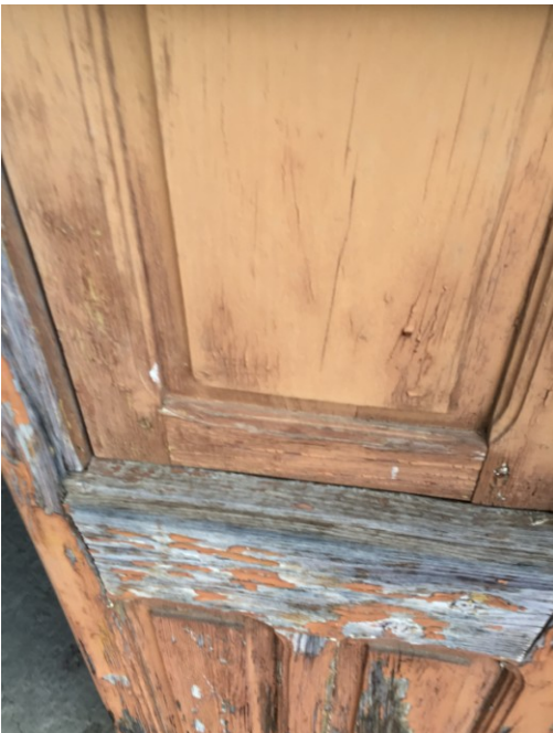
Foto n. 20: Particolare infisso in via Garibaldi, Loceri
