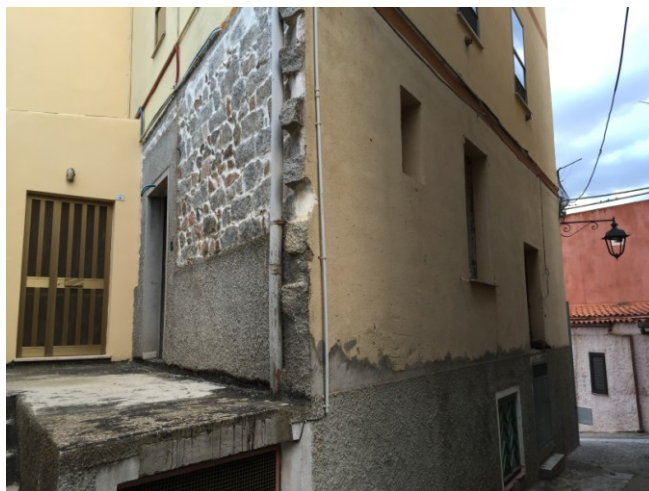
Foto n. 13: Ingresso abitazione in via Garibaldi, Loceri
