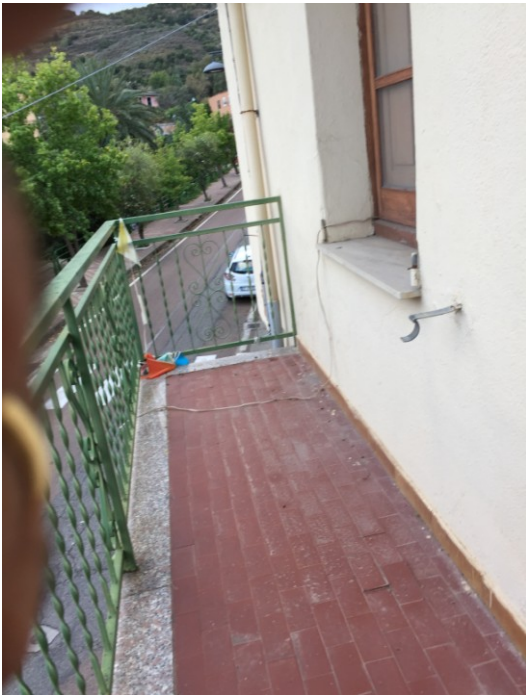
Foto n. 18: Interno abitazione in via Garibaldi, Loceri
