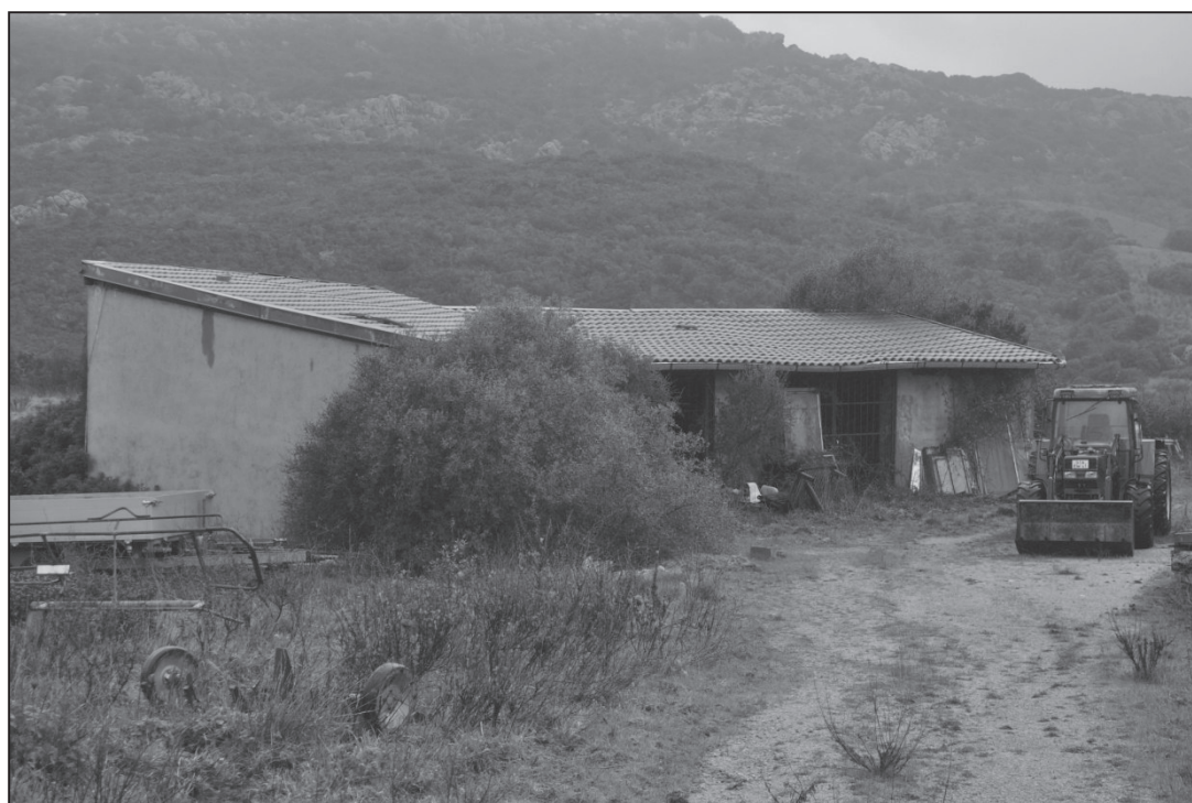
Figg. 27-28. Fabbricato distinto al mappale 294 annesso al terreno distinto al mappale 400 (ex 247) - Prospetto principale
