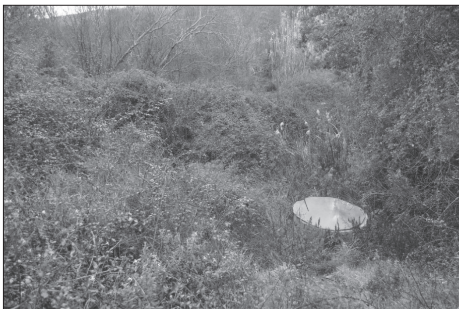
Figg.9-10 .Terreno mappale 19 - Dettaglio del pozzo per rifornimento idrico
