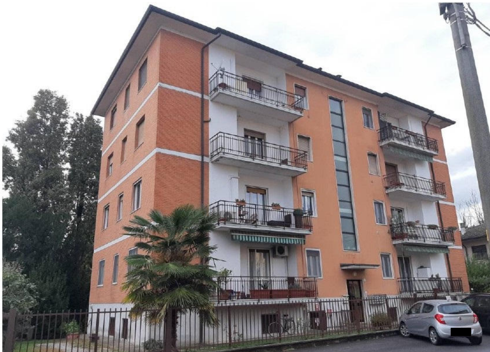
Fabbricato - Lato est
