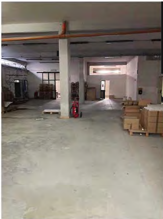
Fotografia n. 21 _ Laboratorio interrato sub 4
