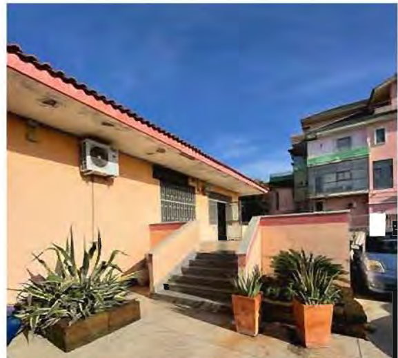
Fotografia n. 2 _ Collegamento del terrazzo antistante gli uffici all'area comune
