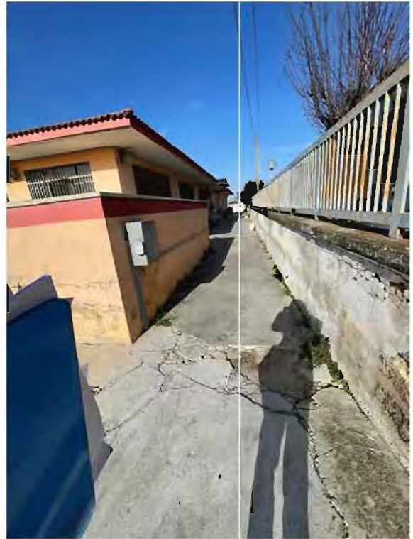
Fotografia n. 6 _ Camminamento e prospetto ovest
