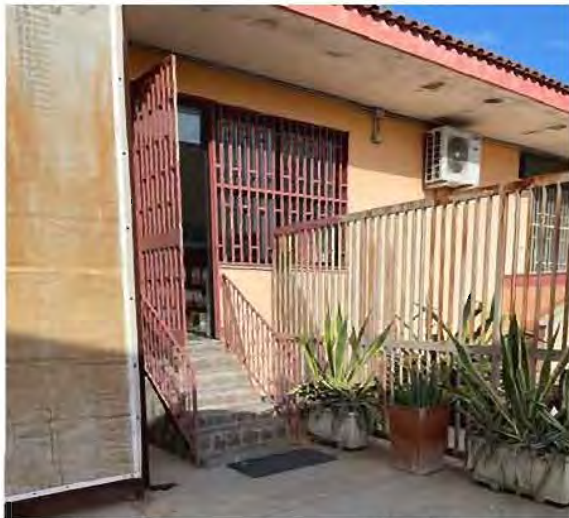
Fotografia n. 1 _ Ingresso agli uffici sub 2
