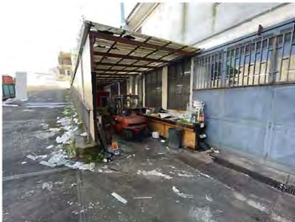
Fotografia n. 11 _ Ingresso al sub 7
