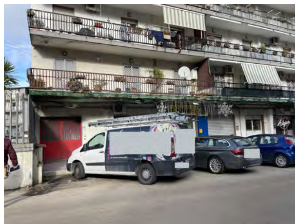
Fotografia n. 2 _ Particolare prospetto su via Fava
