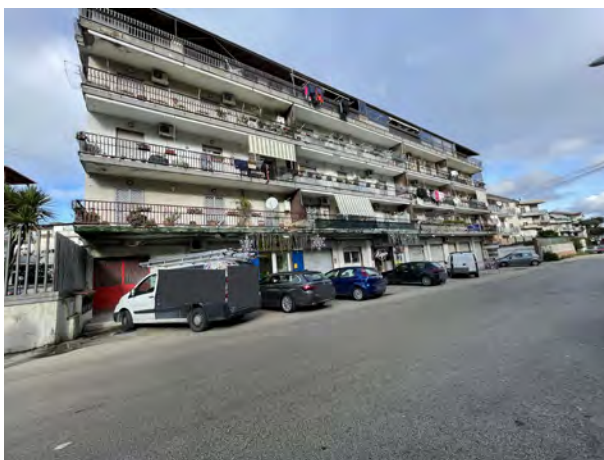
Fotografia n. 1 _ Prospetto su via Fava
