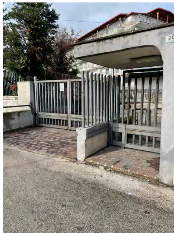
Fotografia n. 4 _ Ingresso all'area comune
