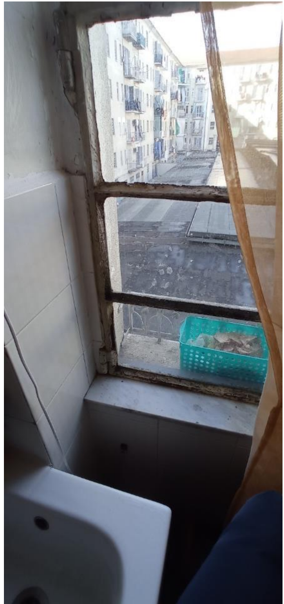
26. Dettaglio serramento cucina
