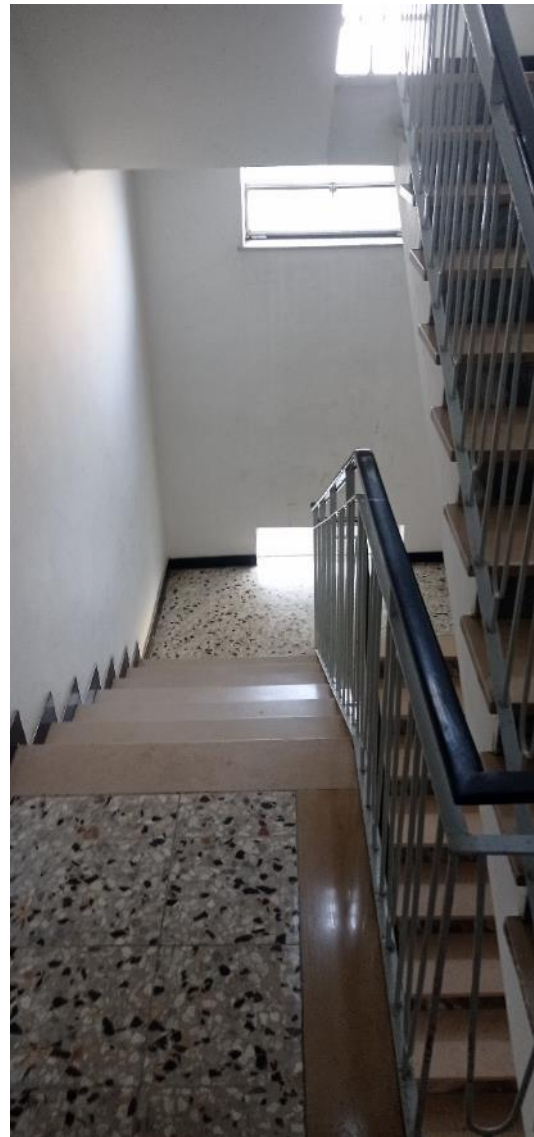
7. Vano scala condominiale
