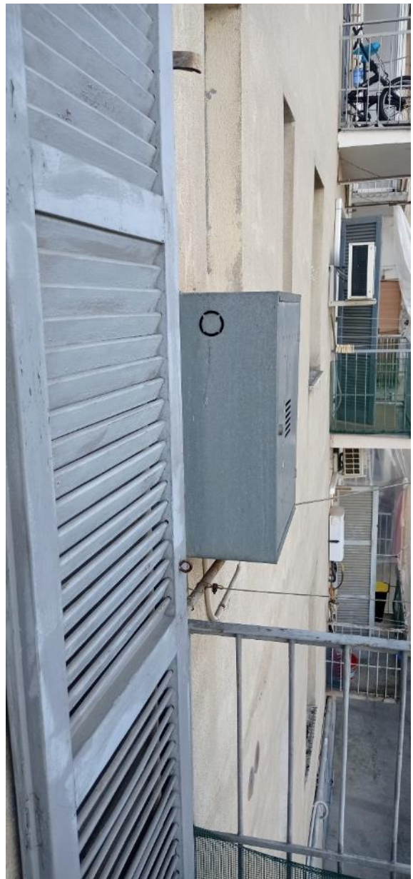
30. Balcone lato cortile interno
