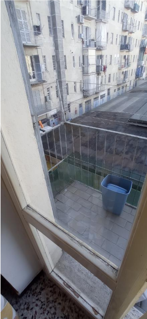
31. Dettaglio serramento lato cortile interno
