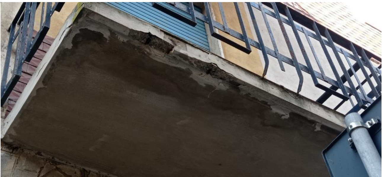
35. Dettaglio balcone su Via Fernandel
