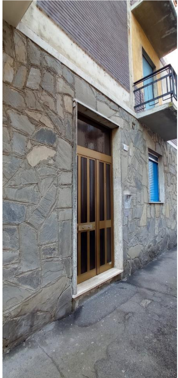
2. Portoncino di ingresso da strada
