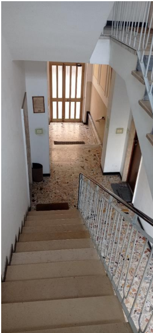
6. Vano scala condominiale
