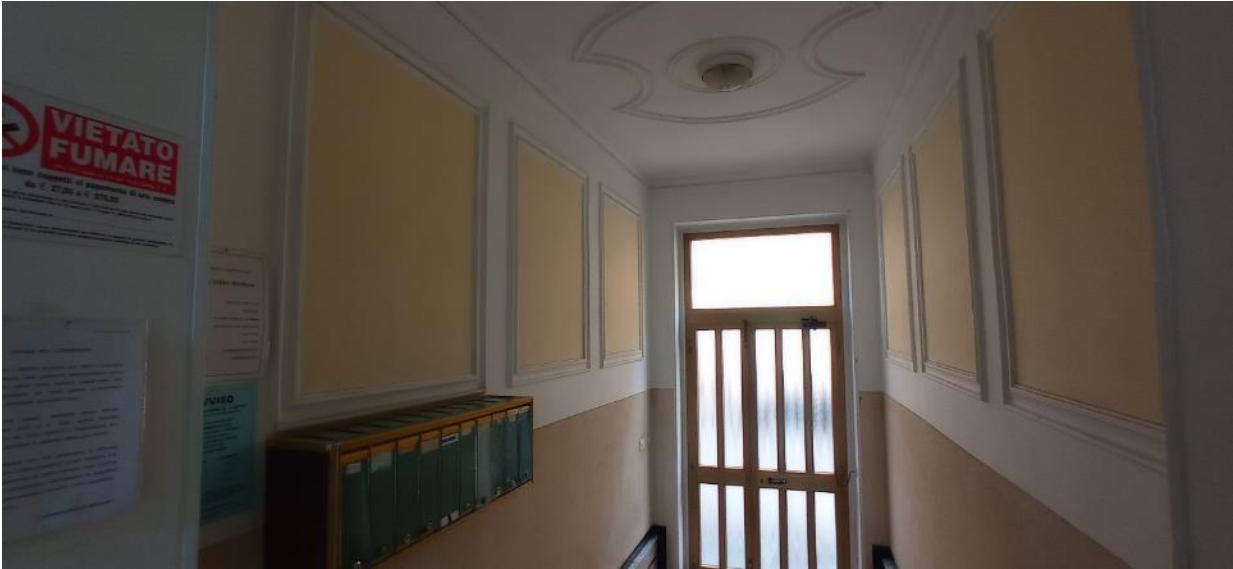
5. Vano scala condominiale
