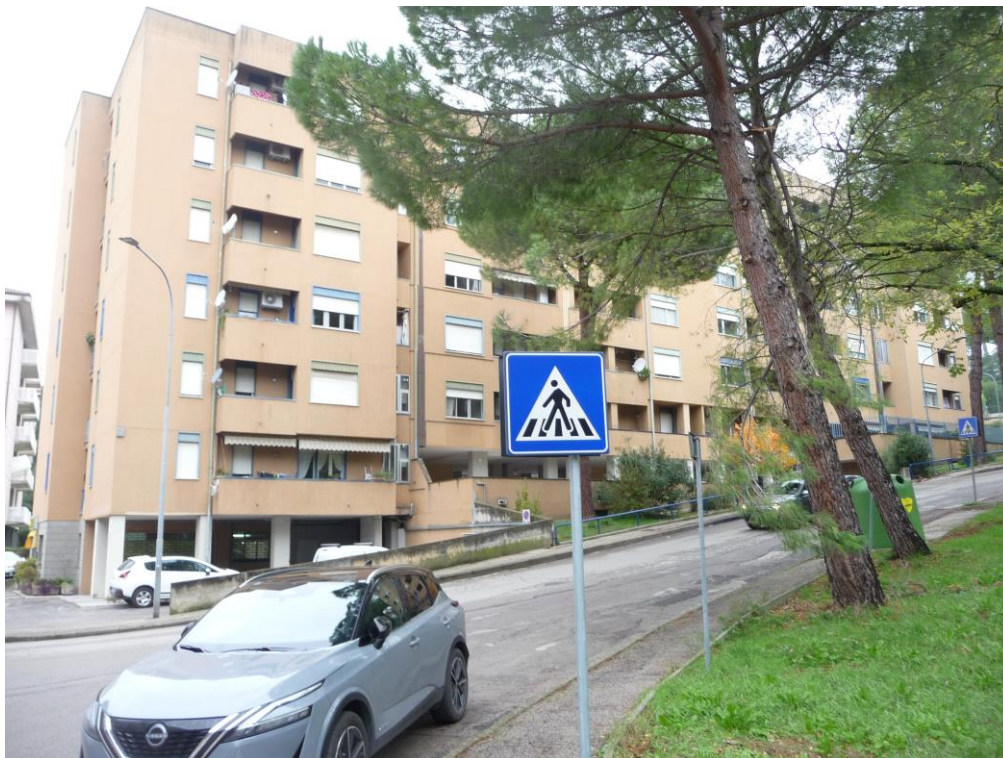
Edificio Via C. Colombo 5/A (altre foto in allegato n. 7)
