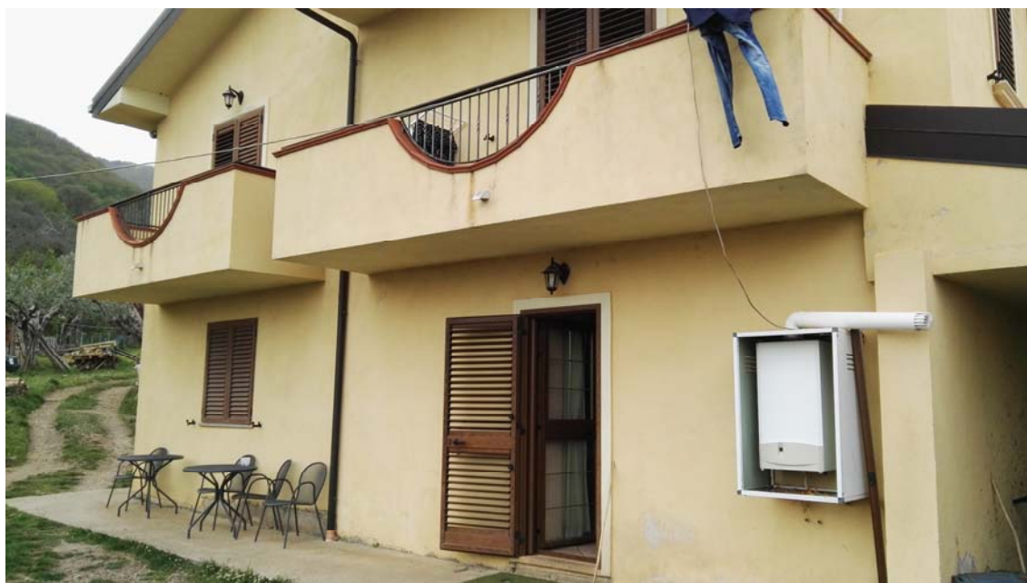
Foto 5: Veduta esterna – lato ovest;
