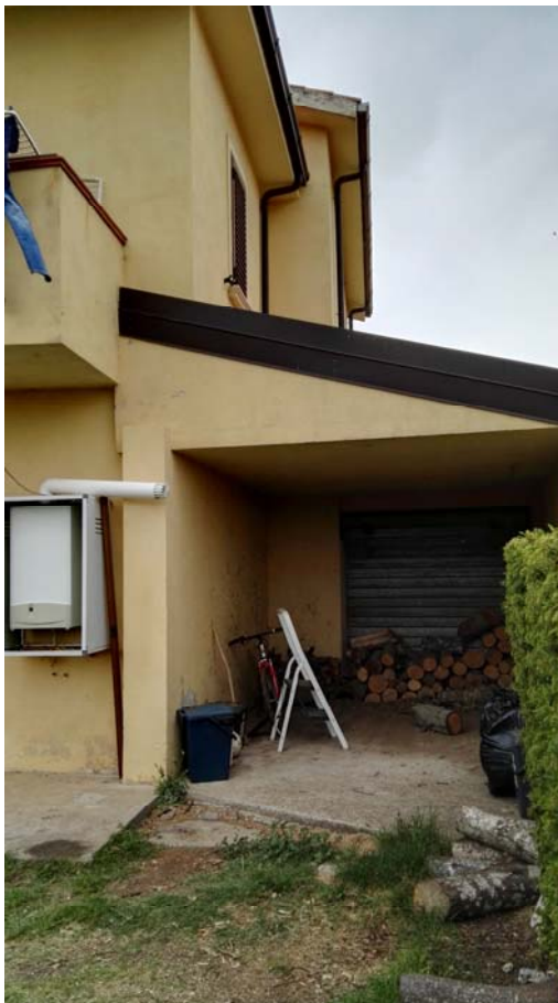
Foto 24: Esterni – lato sud-ovest;
