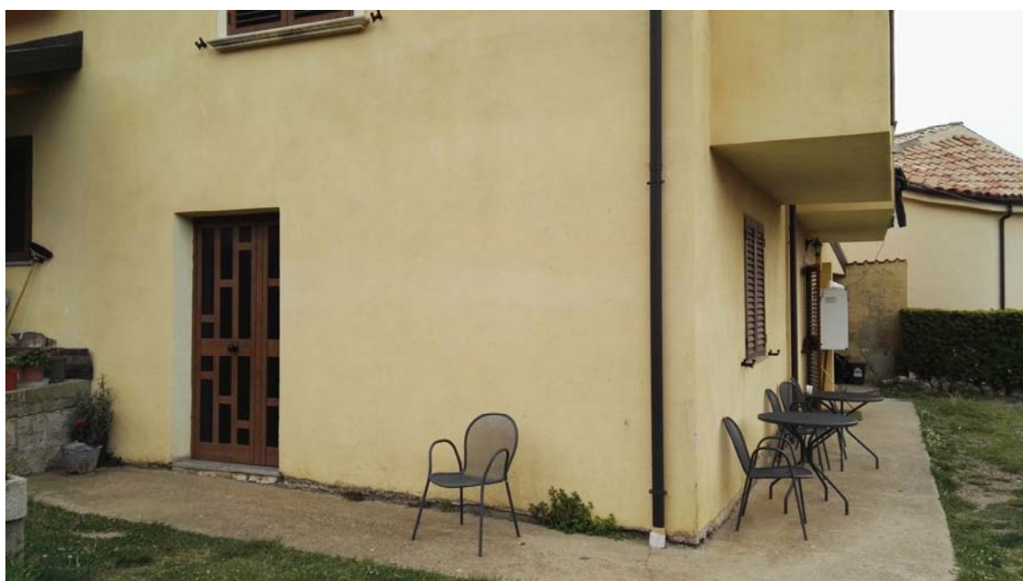
Foto 6: Veduta esterna – lato nord;
