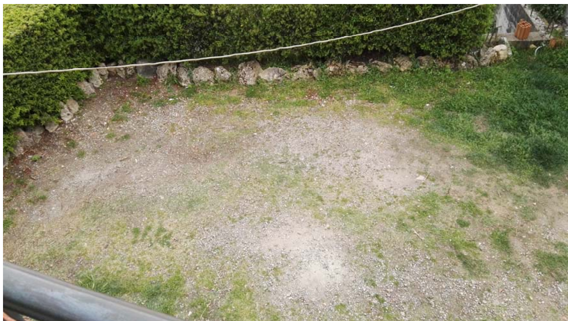
Foto 4: corte lato ovest;
