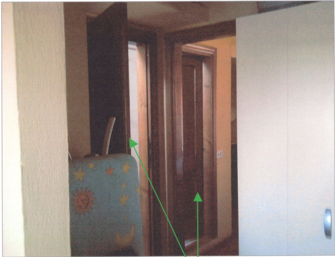
PORTE DI INGRESSO AL BAGNO PIANO SECONDO
