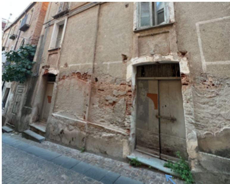
Figura 7 Immobile fg 74 sub 1 _Ingresso
