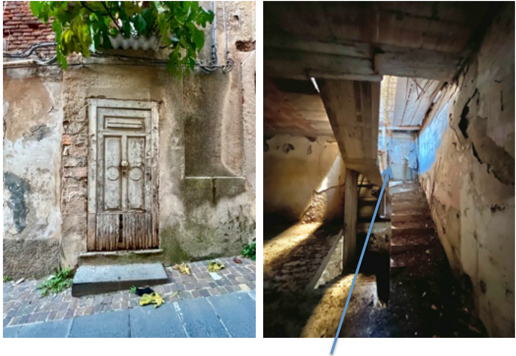
Figura 12 sub 3 _ Porta di accesso originaria su scala che porta al sub 3 posizionato al piano primo
