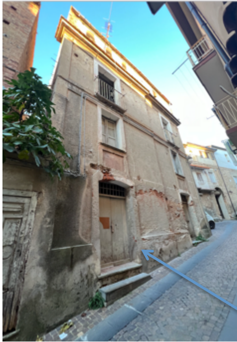
Figura 9 Immobile fg 74 part 426 sub 1-2-3- _ Ingresso sub 2
