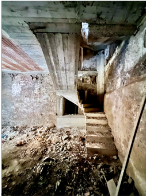
Figura 11 Scala che consente l'accesso al sub 3
