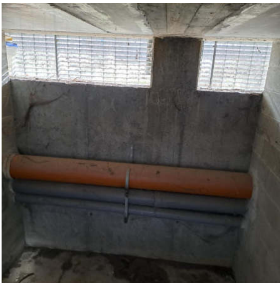
Foto 22 – Cantina al sub 32 – PS1
