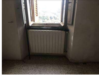
Radiatore locale piano terra
