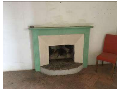
Camino soggiorno piano terra
