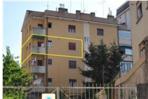
Condominio - Vista da Via Marzio Moro
