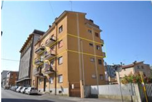
Condominio - Vista da Via Giovanni Randaccio
