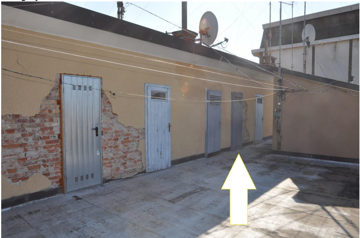
Fotografia n. 16 – Accesso alla lisciaia comune
