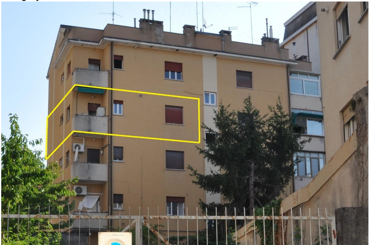
Fotografia n. 2 – Condominio – Vista da Via Marzio Moro
