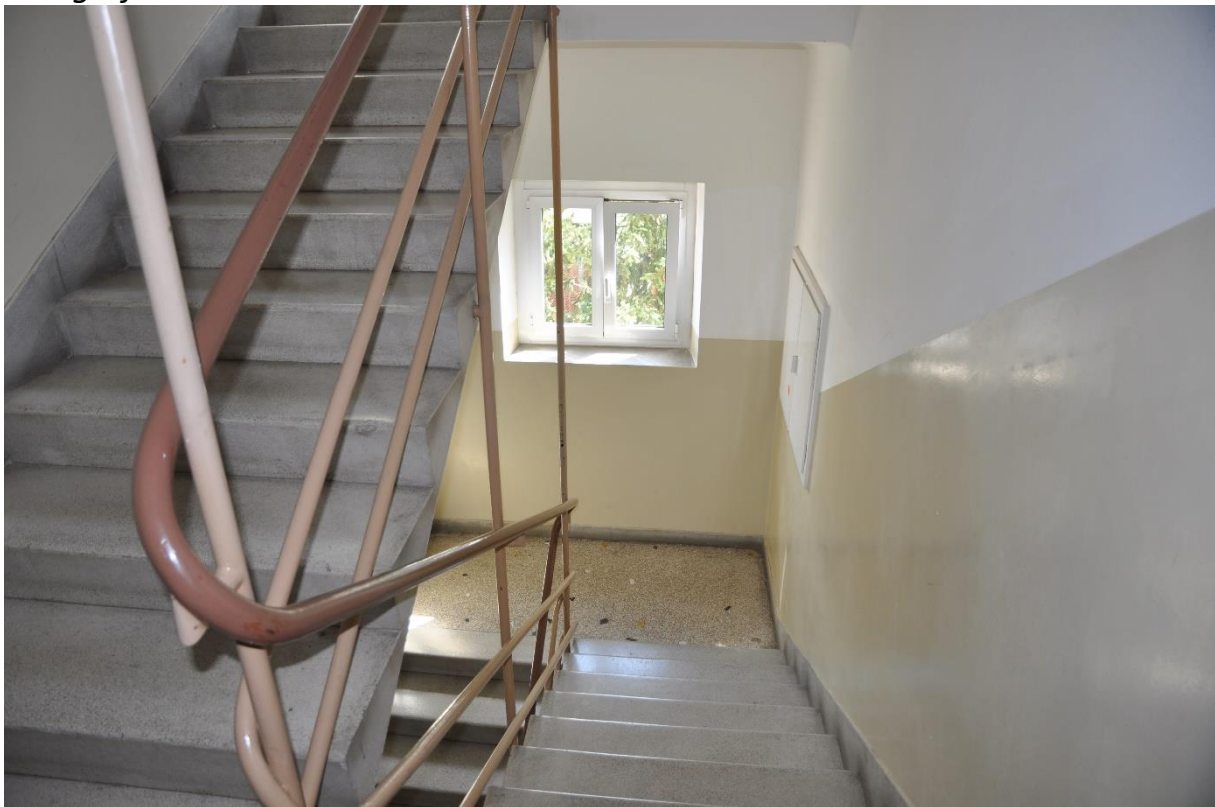
Fotografia n. 4 – Condominio – Vano scale comune
