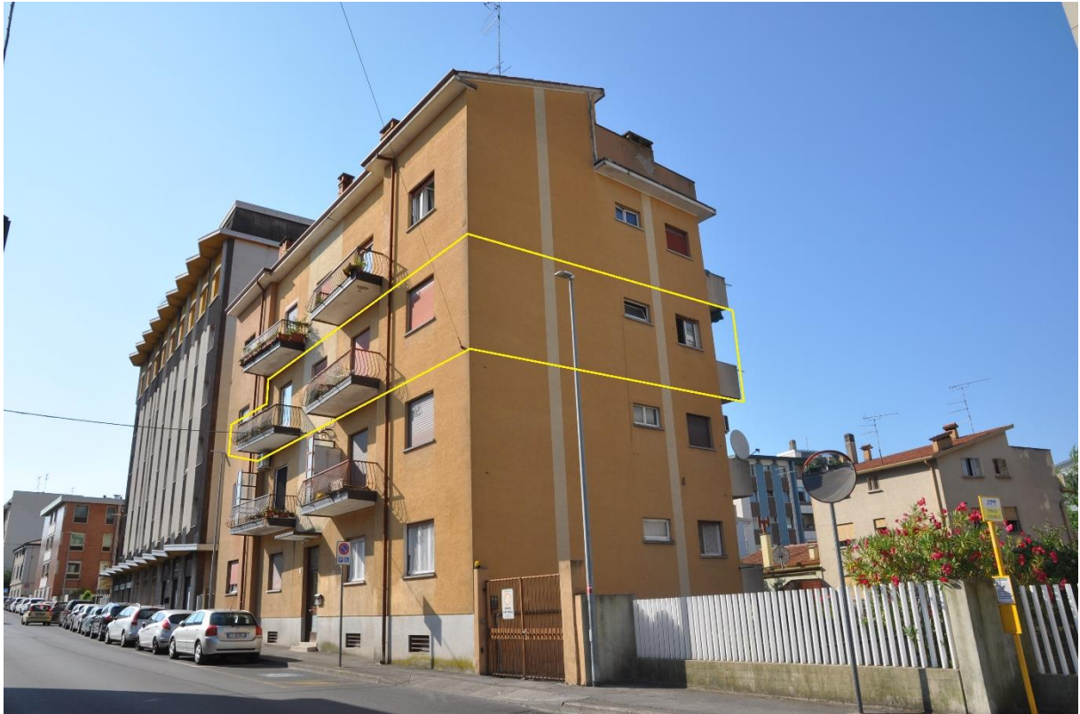
Fotografia n. 1 – Condominio – Vista da Via Giovanni Randaccio
