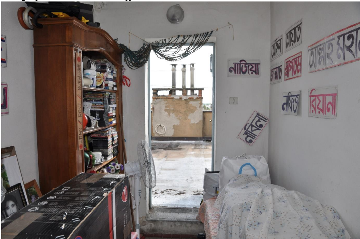
Fotografia n. 6 – Ente F – Soffitta al Piano Quarto
