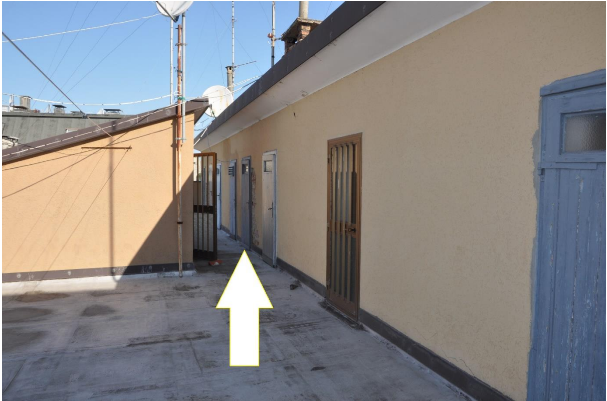
Fotografia n. 15 – Accesso alla lisciaia comune
