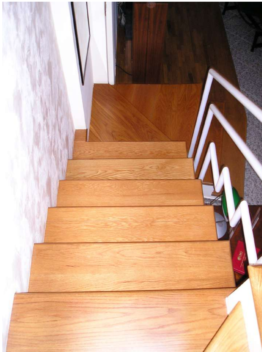
Foto n. 22: Particolare scala interna di collegamento
