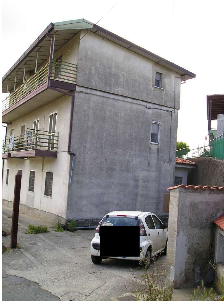
Foto n. 8: Particolare corte del fabbricato e muro a monte
