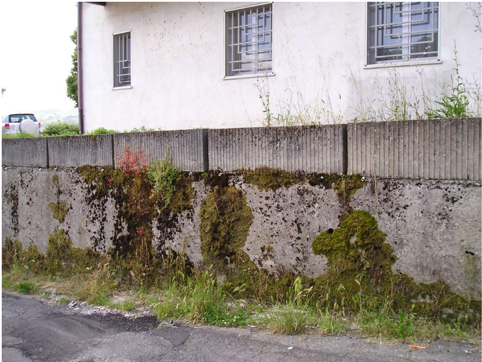
Foto n. 7: Particolare muro a valle del fabbricato
