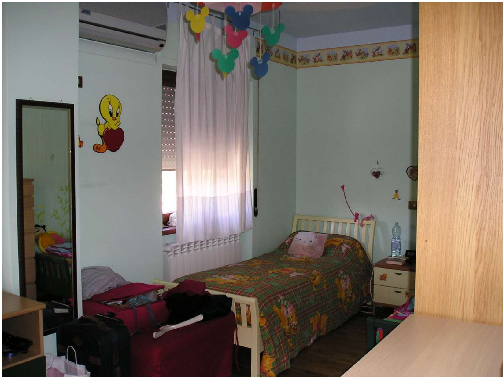
Foto n. 19: Camera da letto con abuso edilizio
