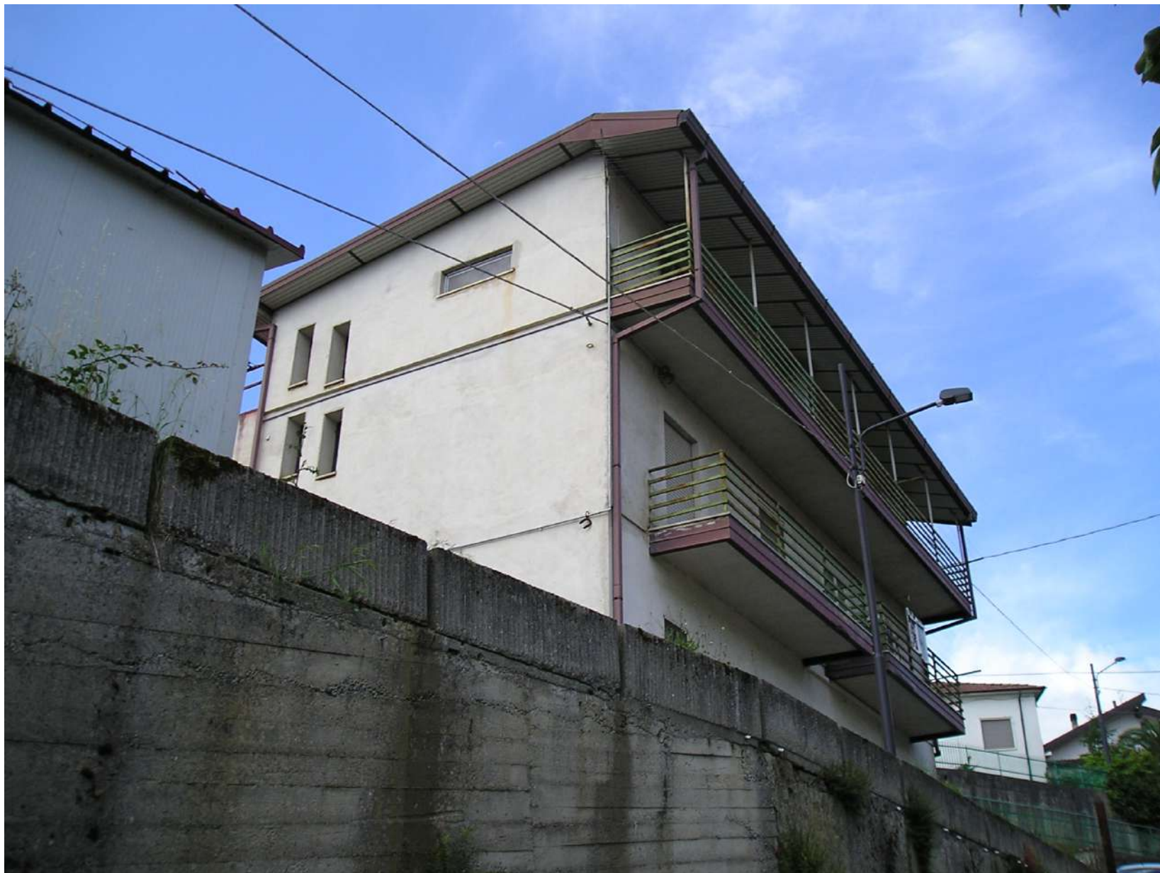
Foto n. 4: Fabbricato di cui fanno parte gli immobili 1 e 2 pignorati
