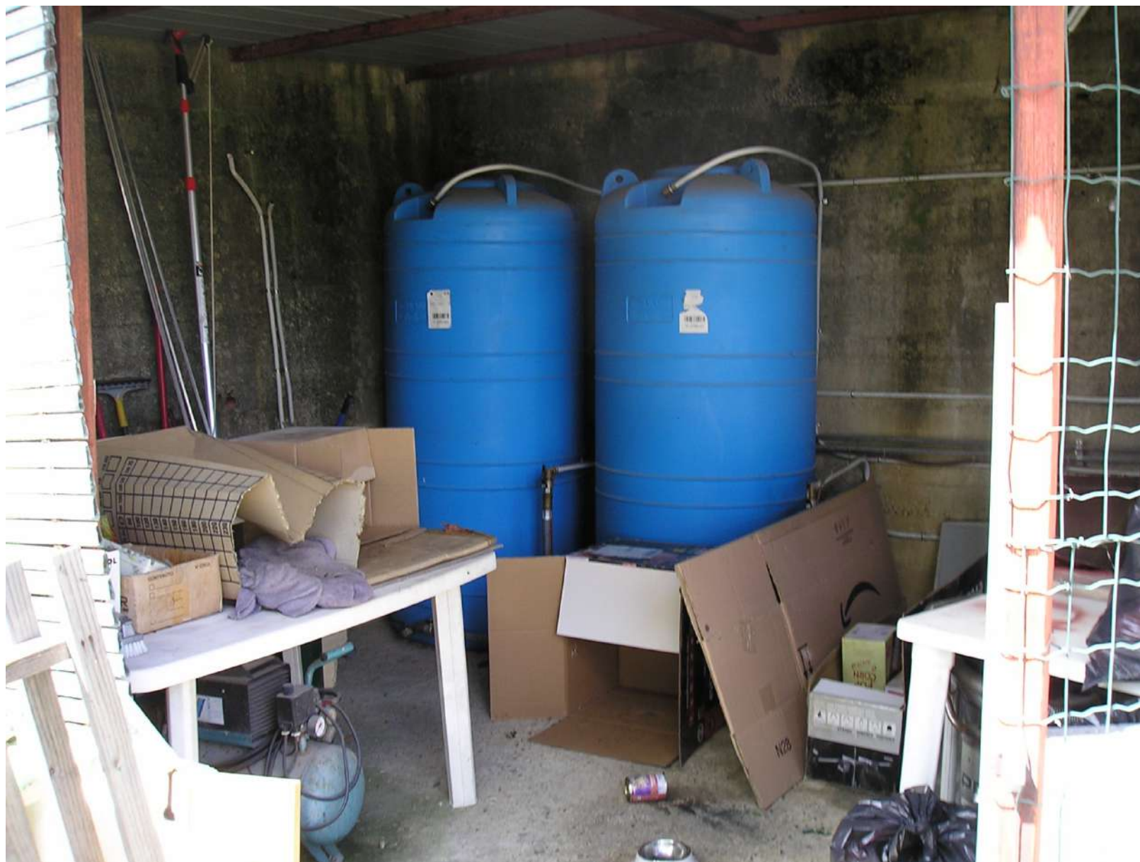
Foto n. 25: Serbatoio autoclave
