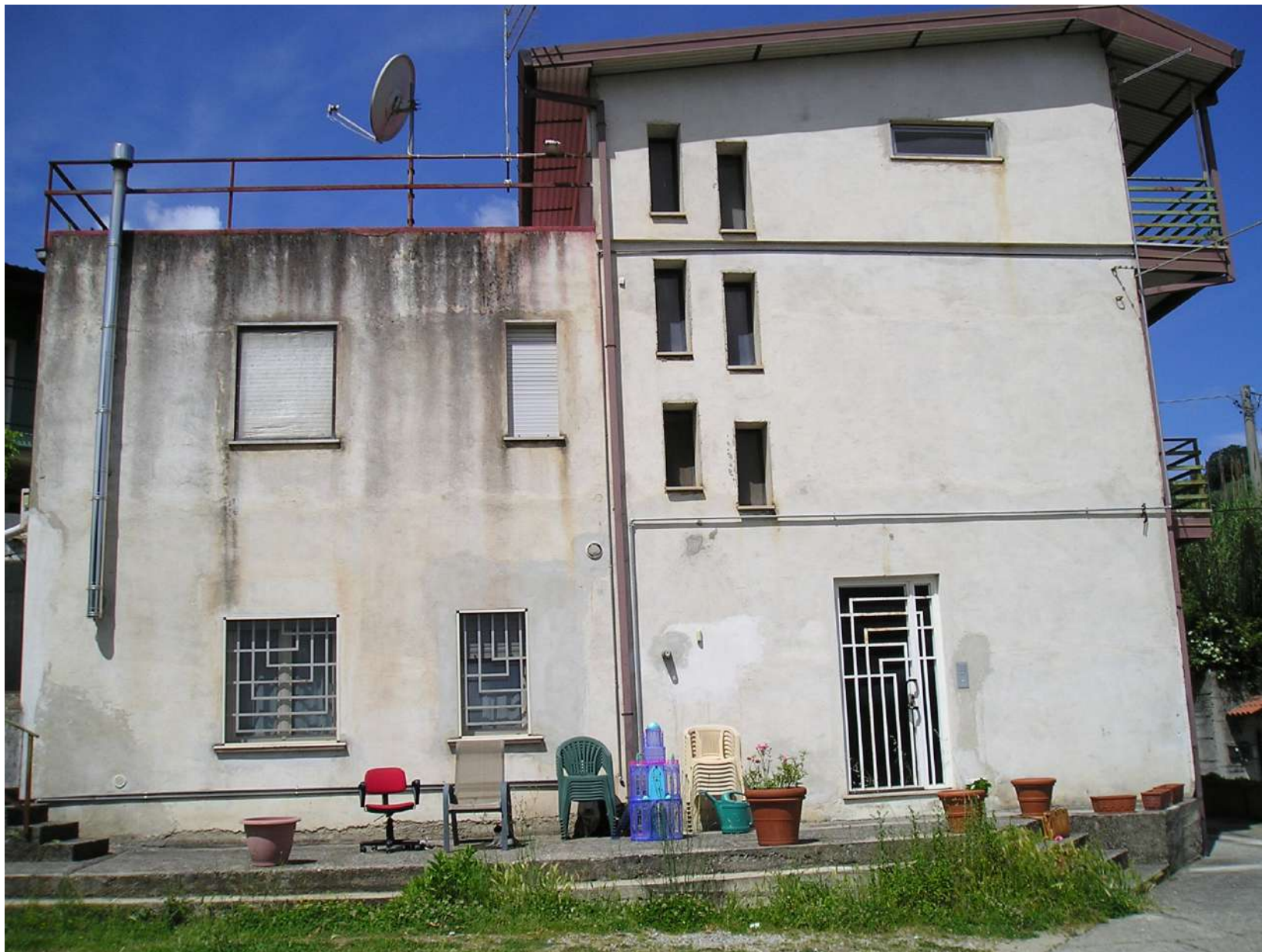
Foto n. 5: Fabbricato di cui fanno parte gli immobili 1 e 2 pignorati
