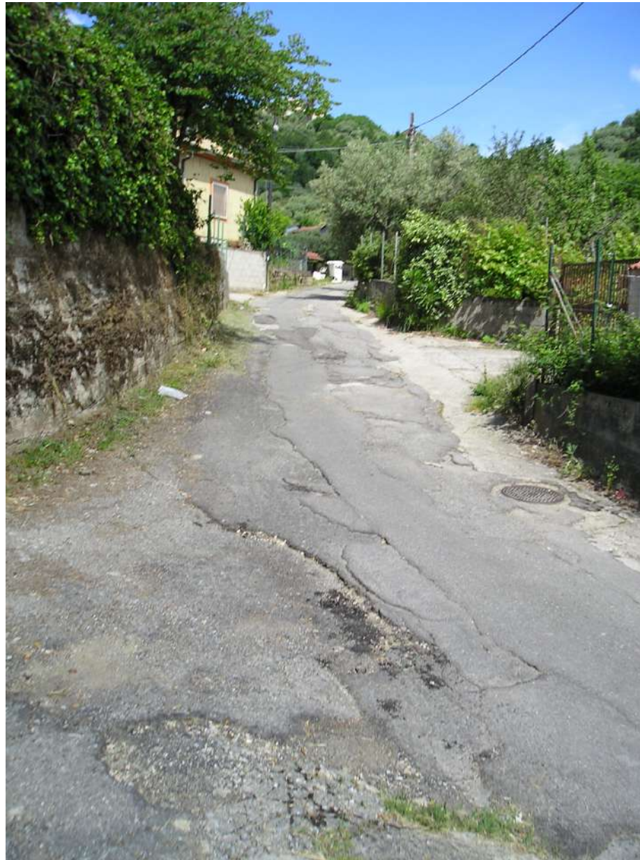
Foto n. 6: Strada di accesso al fabbricato – Via Linze
