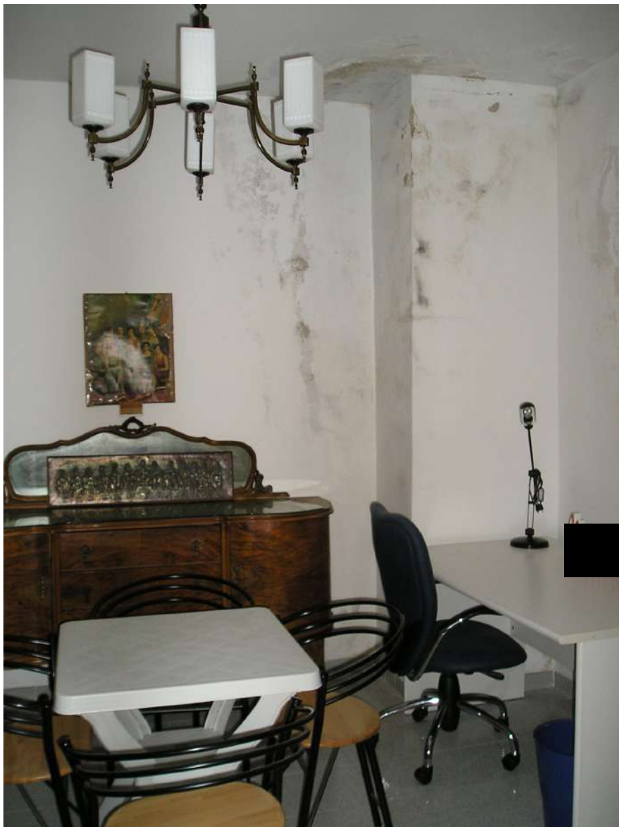
Foto n. 27: Vano pluriuso con presenza di infiltrazioni
