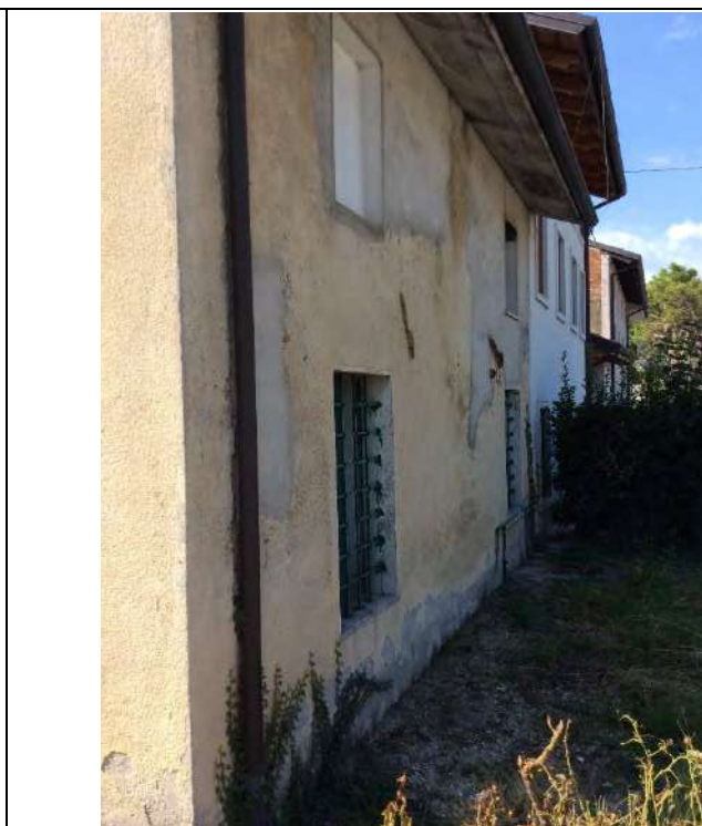
Foto 2: Vista dall'esterno appartamento sub 5 Prospetto nord
