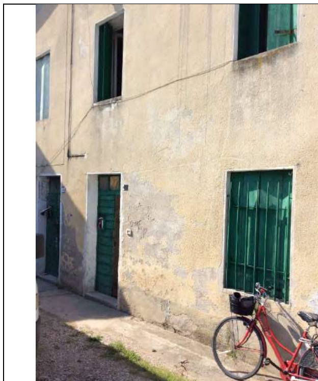
Foto 1: Vista dall'esterno appartamento sub 5 Prospetto est
