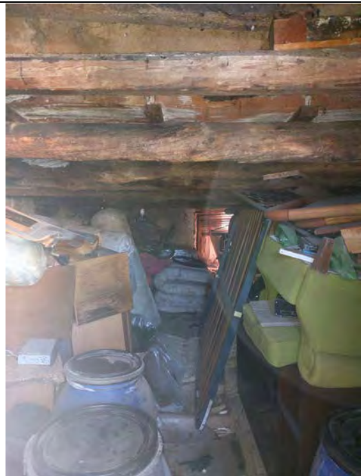
Foto 14: PT Vista dell'interno
