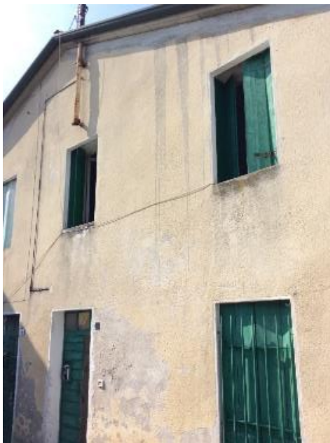
Foto 1: Vista esterna edificio sub 5 parte abitazione
