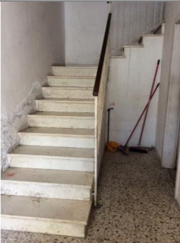
Foto 5: PT - corridoio di ingresso e scala
