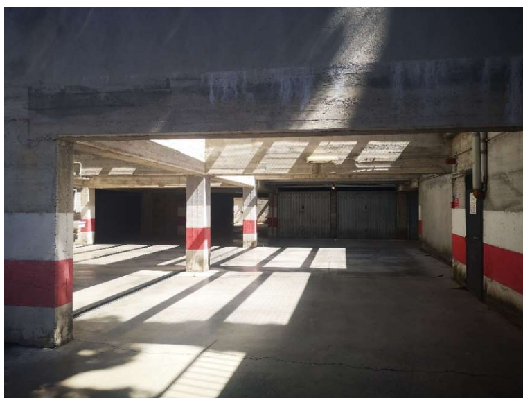
Foto 6 Primo piano interrato dell'autorimessa
