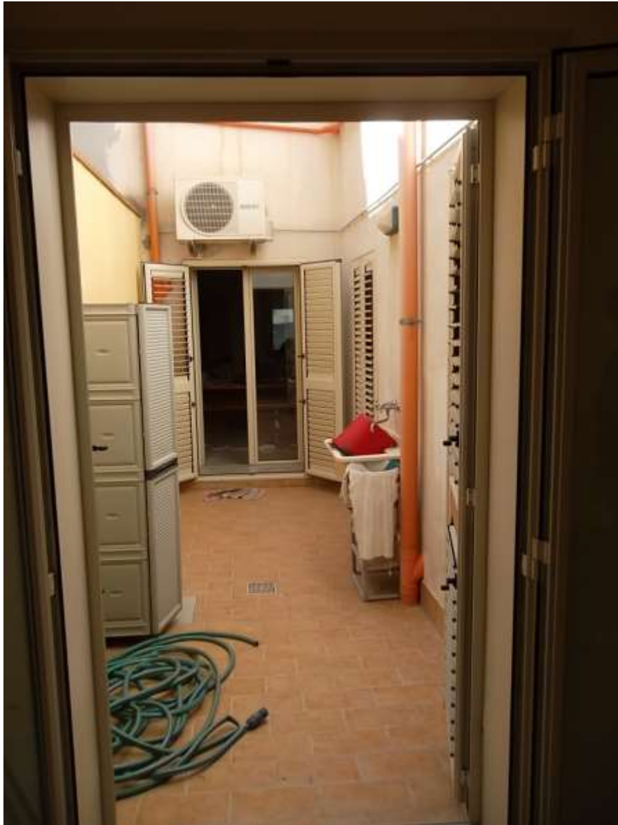
Foto 8– Immobile “1A” – Pozzo luce a piano terra
