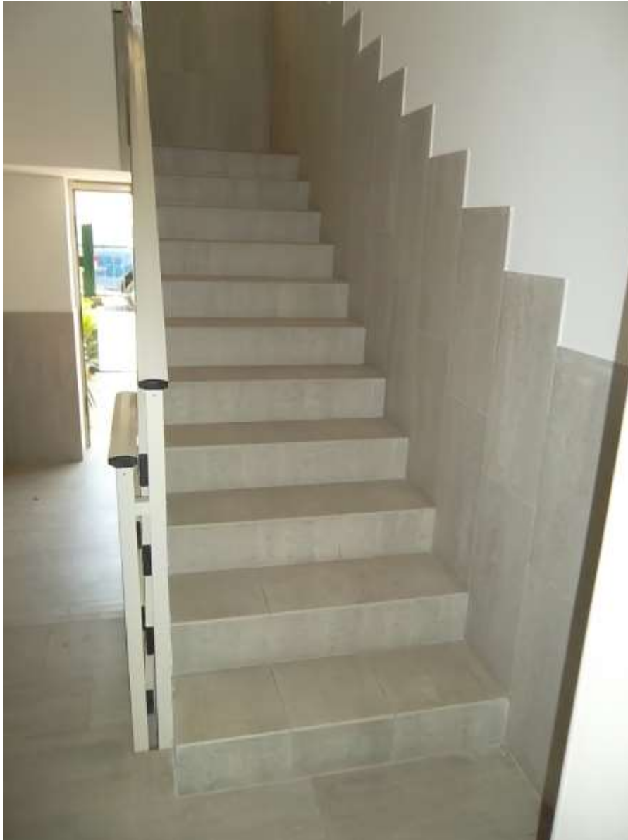
Foto 10 – Immobile “1A” – Rampa n. 1 della scala da piano terra a primo piano
