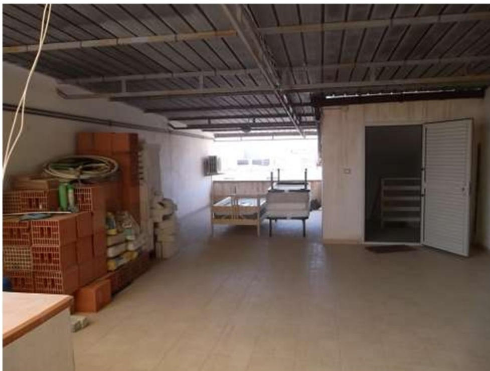
Foto 16 – Immobile "1A" – Lastrico solare a secondo piano, vista lato sud
