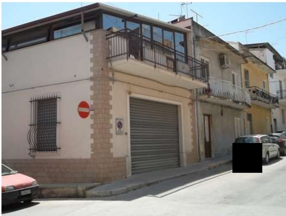
Foto 19 – Immobile “2A” – Prospetto su via Delle Cave
