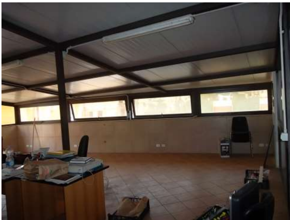
Foto 26 – Immobile “2A” – Deposito a primo piano, lato via Agro Priolese
