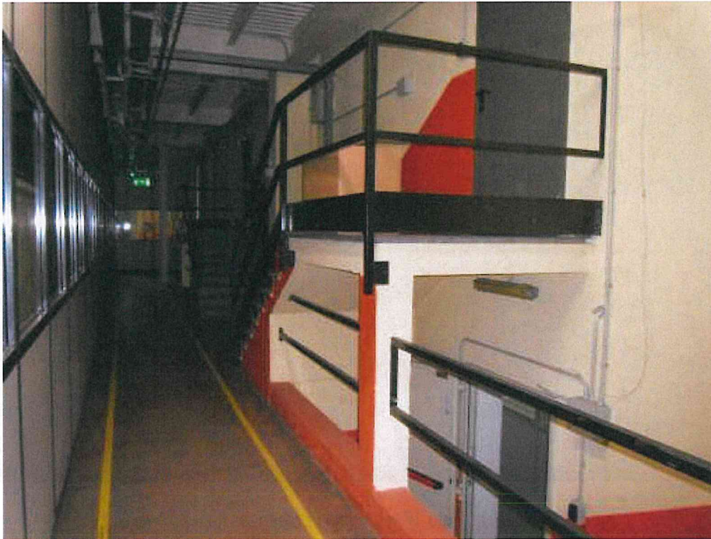
Foto 01 – Dalla produzione l'accesso al piano seminterrato
