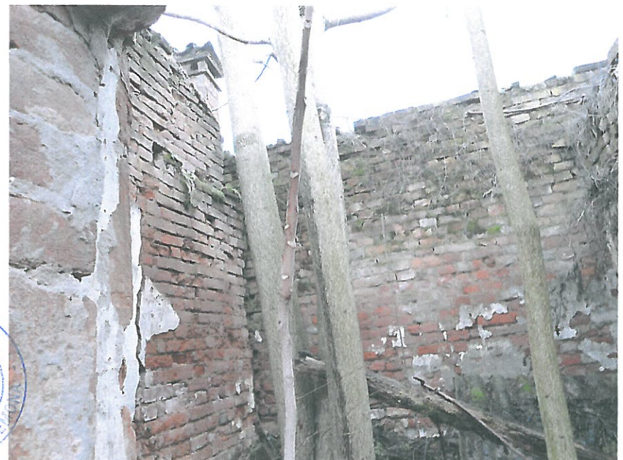
FOTO 31 - INTERNO FABBRICATO 5- FABBRICATO ACCESSORIO
