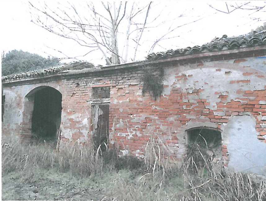
FOTO 28 – PROSPETTO FABBRICATO 5- FABBRICATO ACCESSORIO
