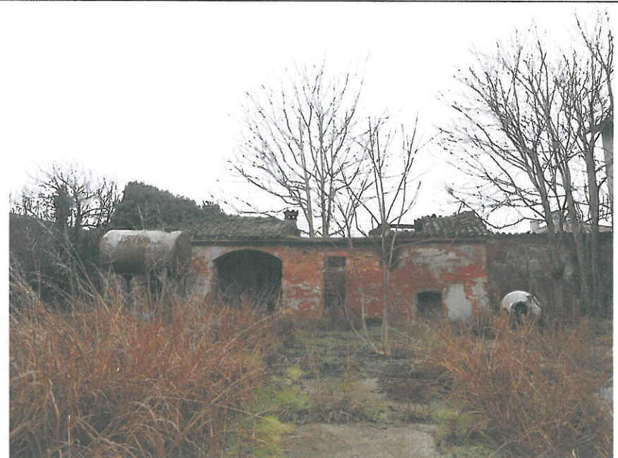
FOTO 29 - PROSPETTO FABBRICATO 5- FABBRICATO ACCESSORIO
