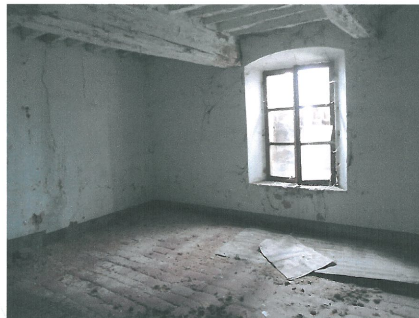
FOTO N. 24 INTERNI PIANO PRIMO FABBRICATO 3
