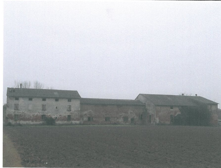
FOTO 2 – PROSPETTO SU STRADA LATO NORD
