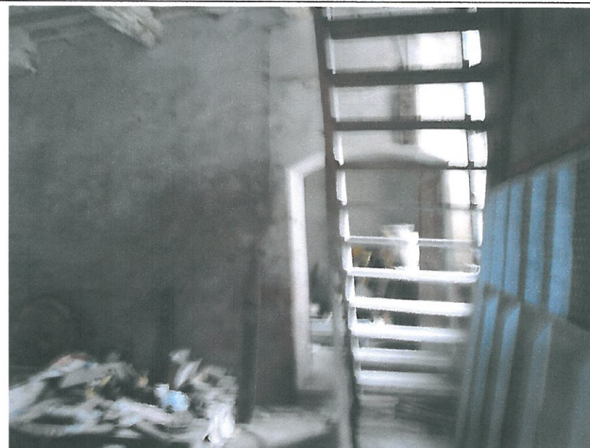
FOTO 6 – INTERNI FABBRICATO 1 – VANO 8
