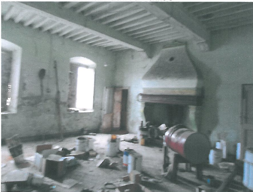
FOTO 11 – INTERNI PIANO PRIMO FABBRICATO 1- VANO 19
