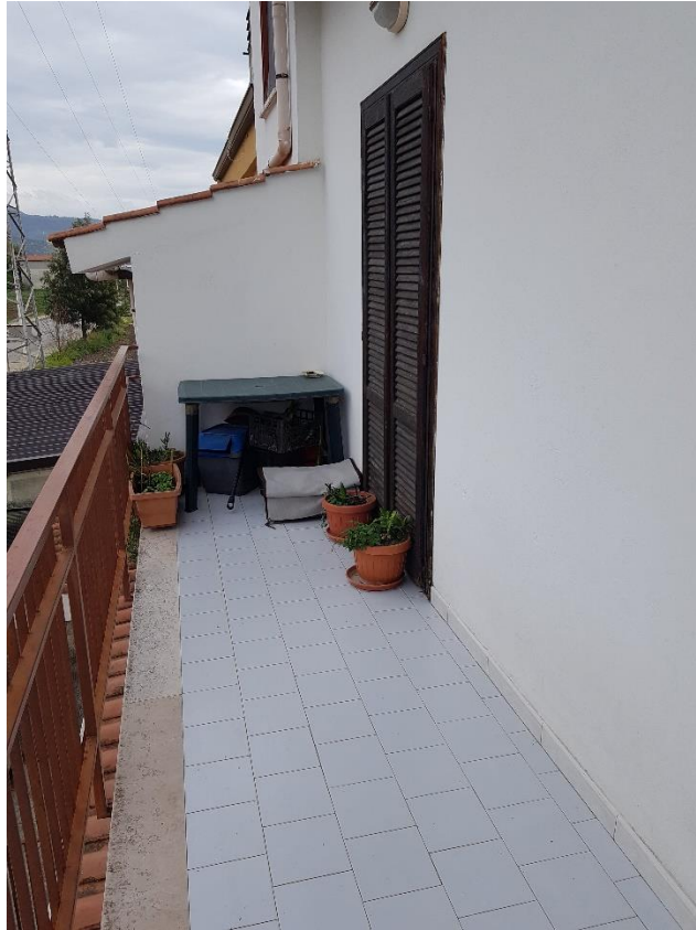
Foto n.8a: balcone facciata est, vista da nord
