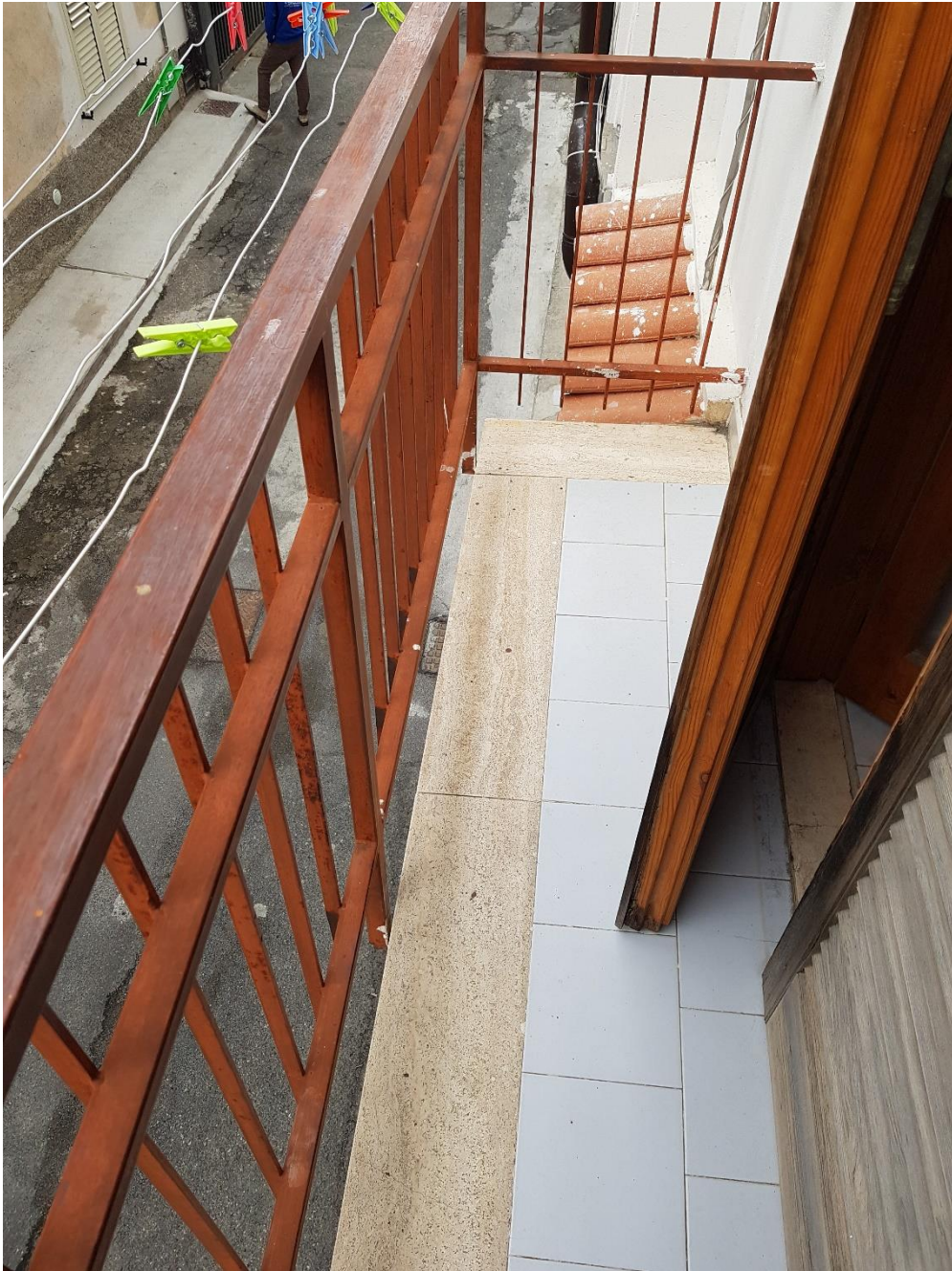
Foto n.11: particolare balcone su facciata ovest
