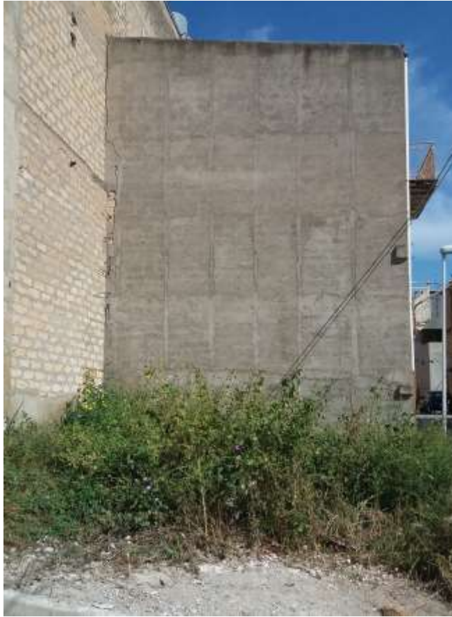
FOTO 3 - Veduta del prospetto laterale;
