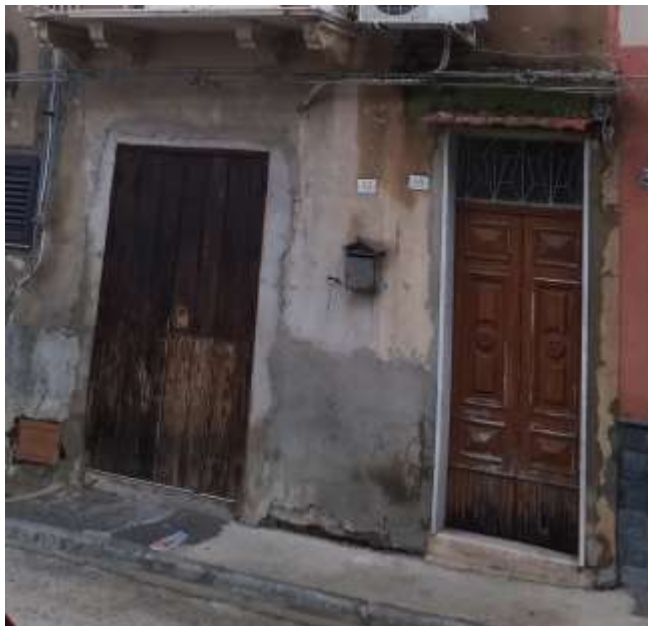
FOTO 2 - Veduta del portone d'ingresso
