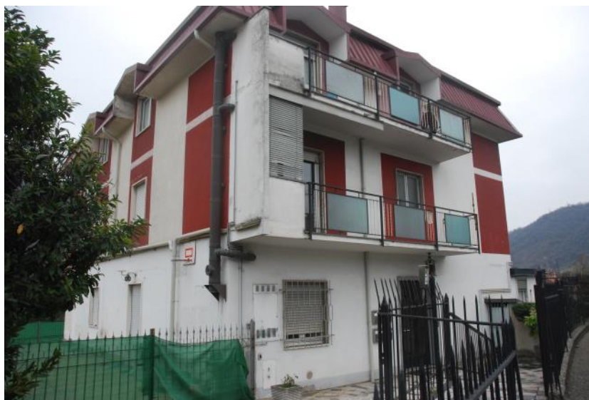
Fronte su via Trento
