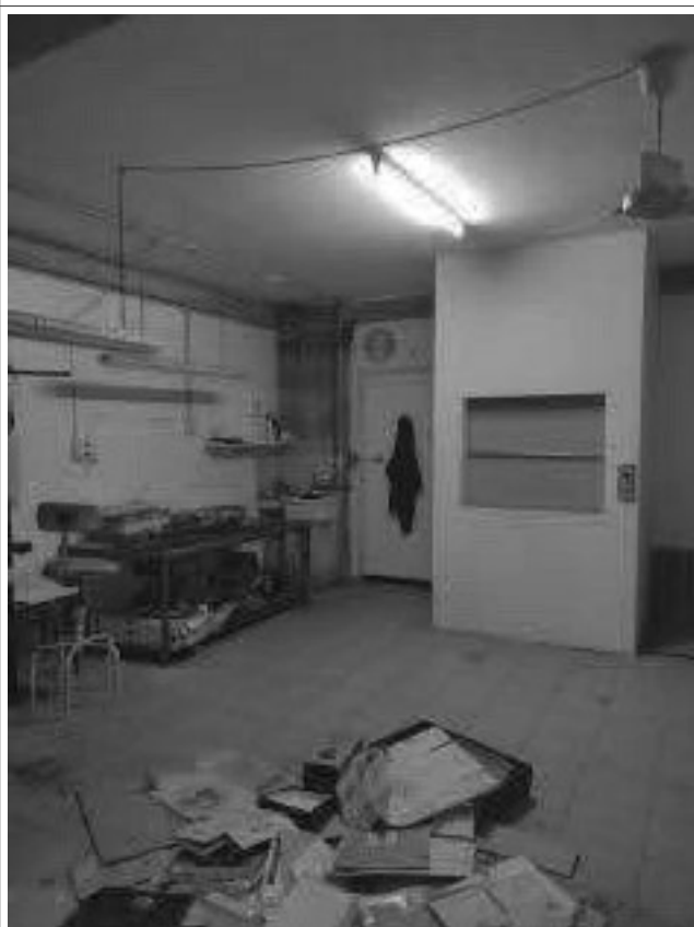
Interno deposito sub 13
