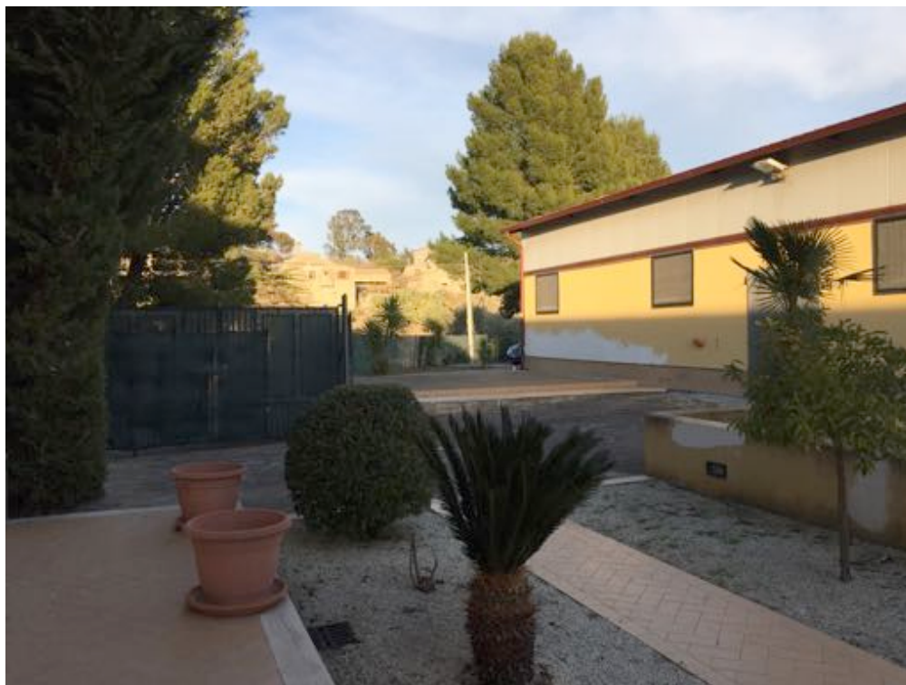
Foto 18 – Corte bene 1 e cancello d'accesso al lotto 2 -
