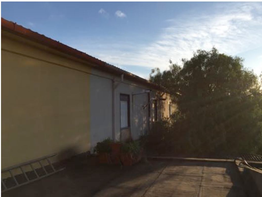
Foto 36 – Accesso alla copertura -
