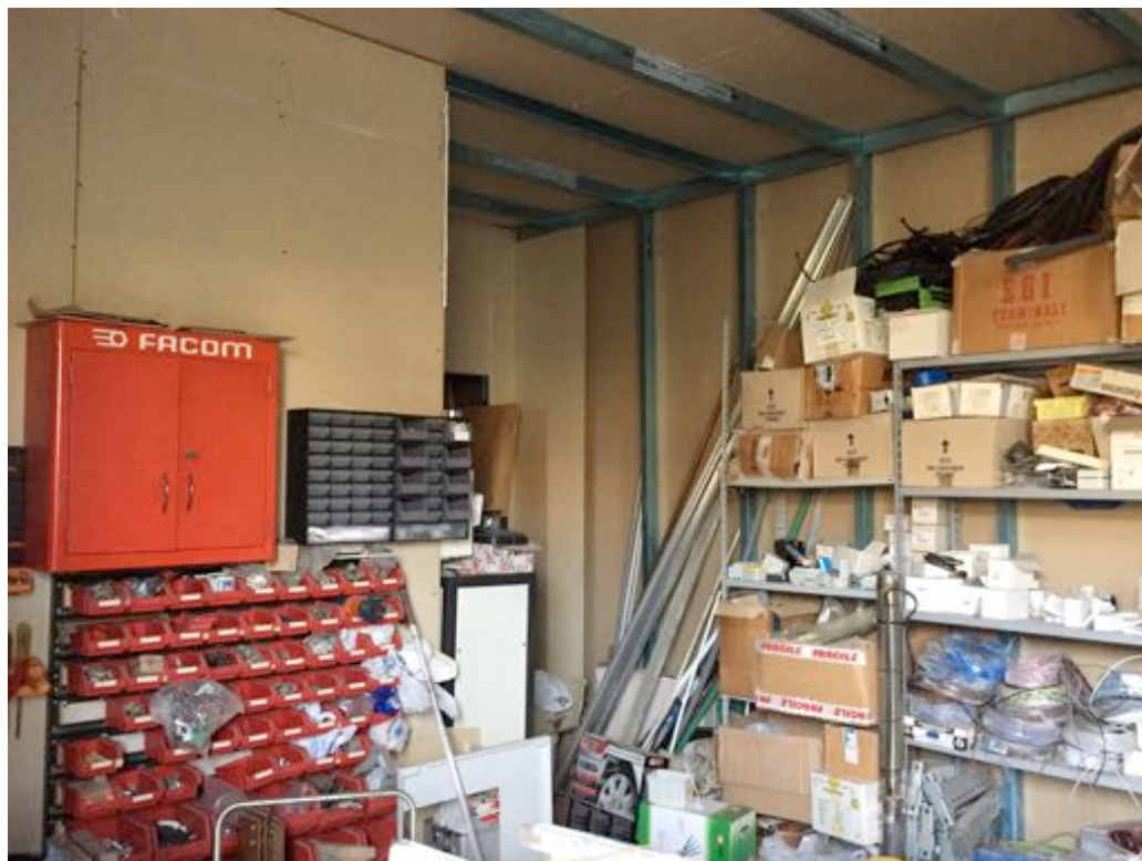
Foto 16 – Locale deposito (variazione interna abusiva da eliminare) -
