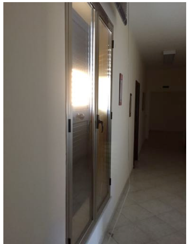
Foto 35 – Portafinestra punto di accesso alla copertura
